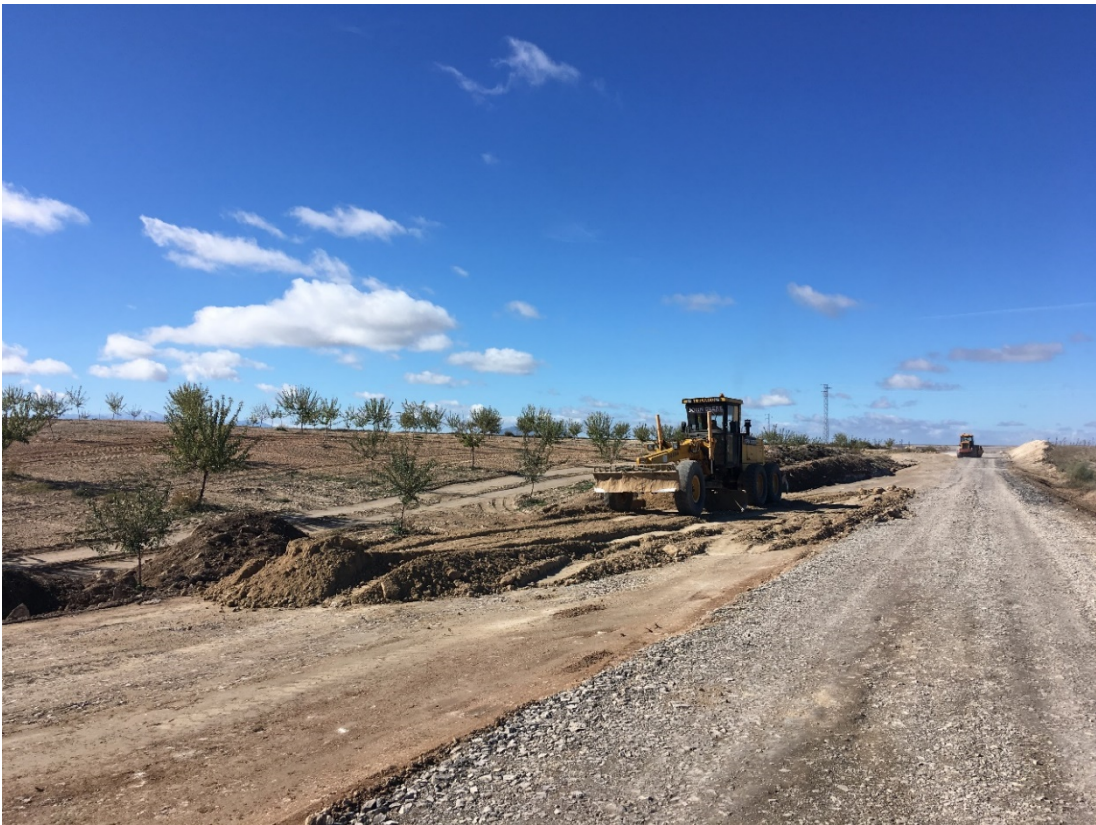
Imagen 2. Relleno de la plataforma para nivelar el P.K. 1+940 a 3+980, GR-9107.
