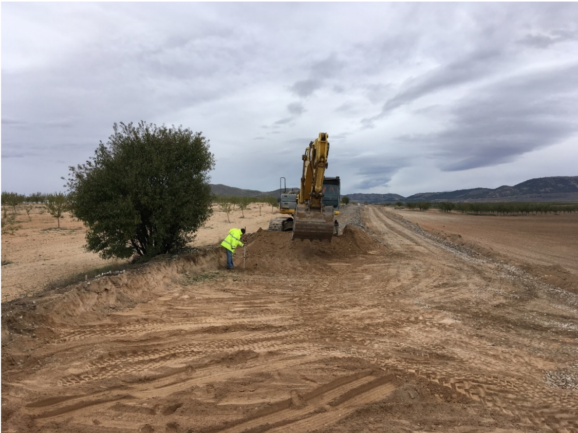
Imagen 1. Excavación completa de la plataforma, P.K. 1+940 a 3+980, GR-9107.
