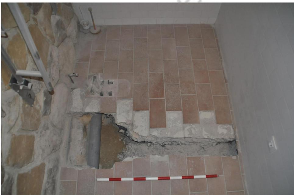
Fig. 4. Zanjas realizadas en el cuarto de baño actual de minusválidos. Se observa el tubo donde se acoplará el nuevo saneamiento procedente del habitáculo colindante. Bajo este tubo se puede ver el suelo terrizo de la Tercia.
