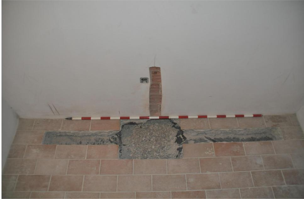
Fig. 5. Zanjas para tubos y arqueta del nuevo espacio de servicios. Se observa la tela plástica de aislante del pavimento y la capa de grava bajo esta.
