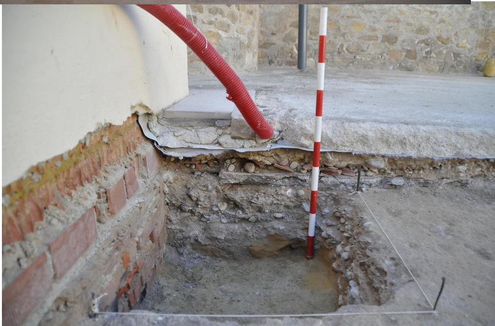
Fig. 2. Detalle del sondeo en el que se aprecia el banco geológico dispuesto bajo el suelo de la antigua bodega
