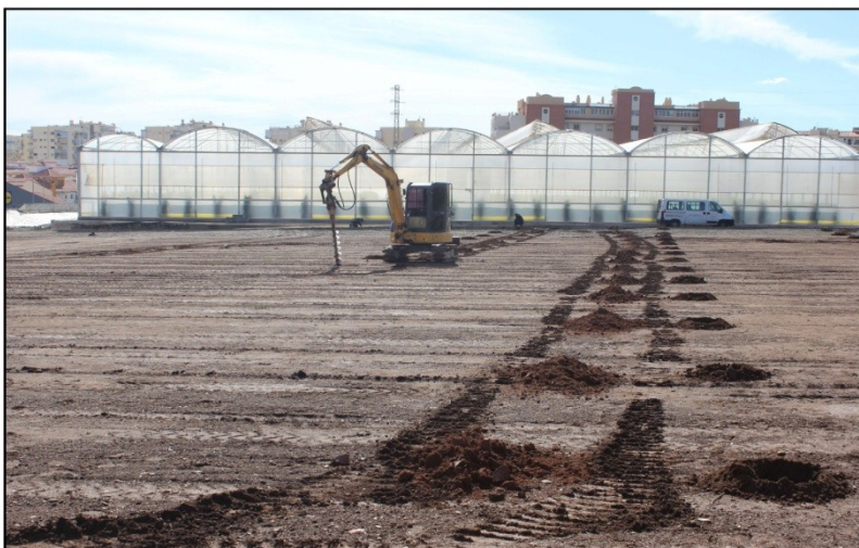
Lám.III. SEGUIMIENTO PERFORACIONES.
