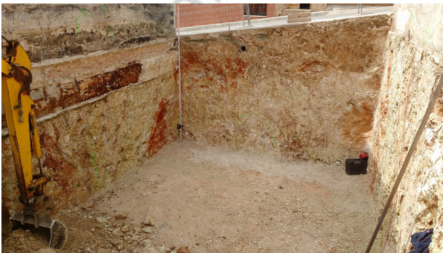
Lámina 2. Final de excavación del primer batache.
