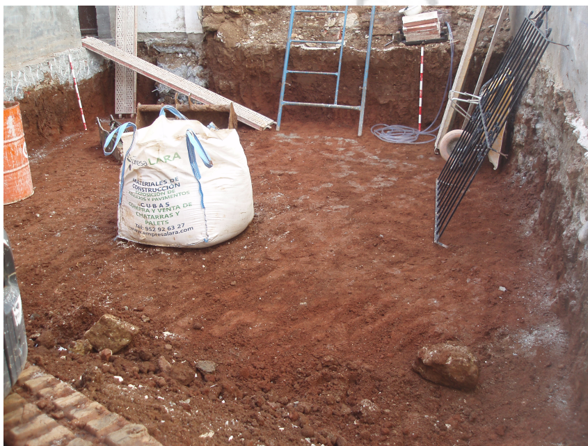
Lámina 1. Vista final del solar.
