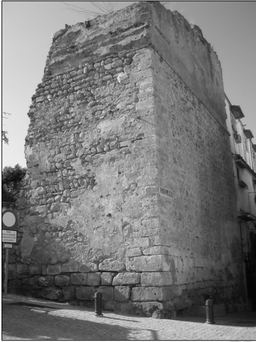
Fig. I. Torre de la Puente Levadiza o de la Campana de la Vela . Se trata de un elemento estructural que guarnecía el ángulo noroeste de la fortaleza, en la actualidad desconectada del lienzo norte a partir de la apertura de la calle Escuelas. Archivo: ARQUEOSUR, S.L.
