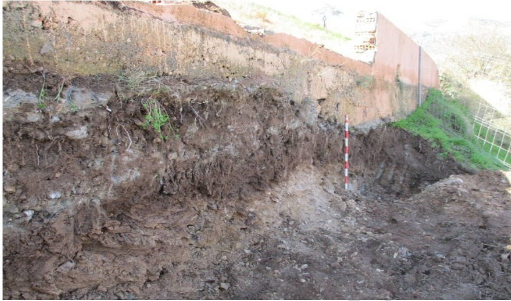
Lám. b. Excavación para cimentación de nuevo muro.
