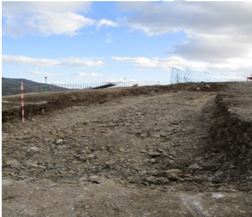
Lám. c. Cajeo para la cimentación y anclaje del nuevo mirador.
