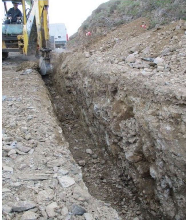
Lám. d. Excavación zapata corrida para riostra.
