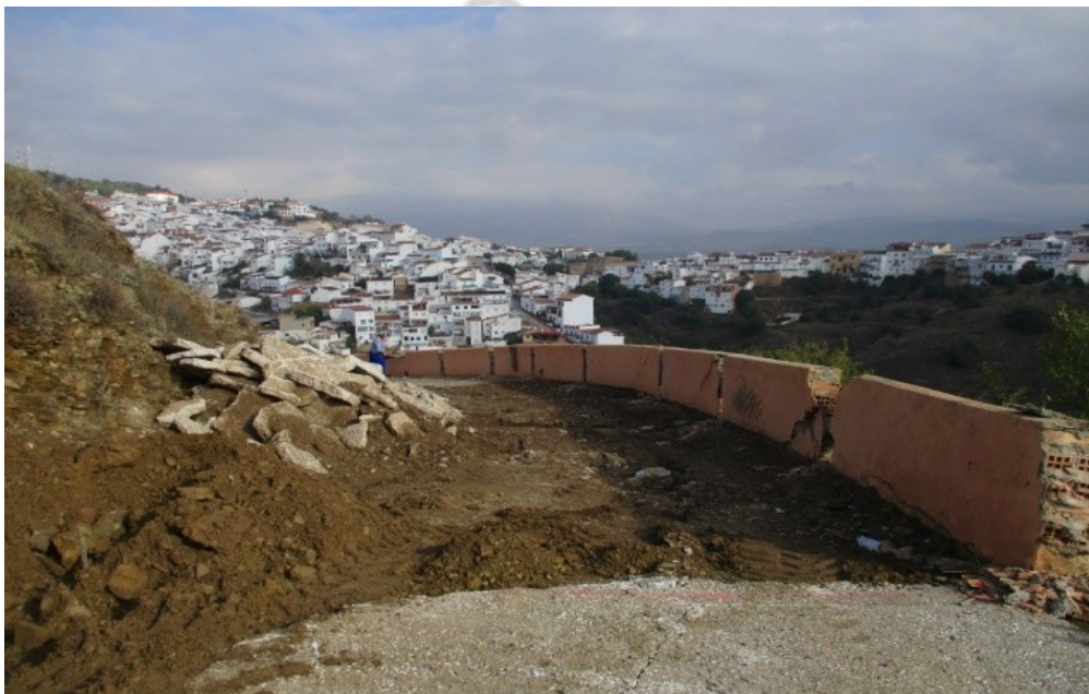
Lám. a. Demolición pavimento y murete actual.
