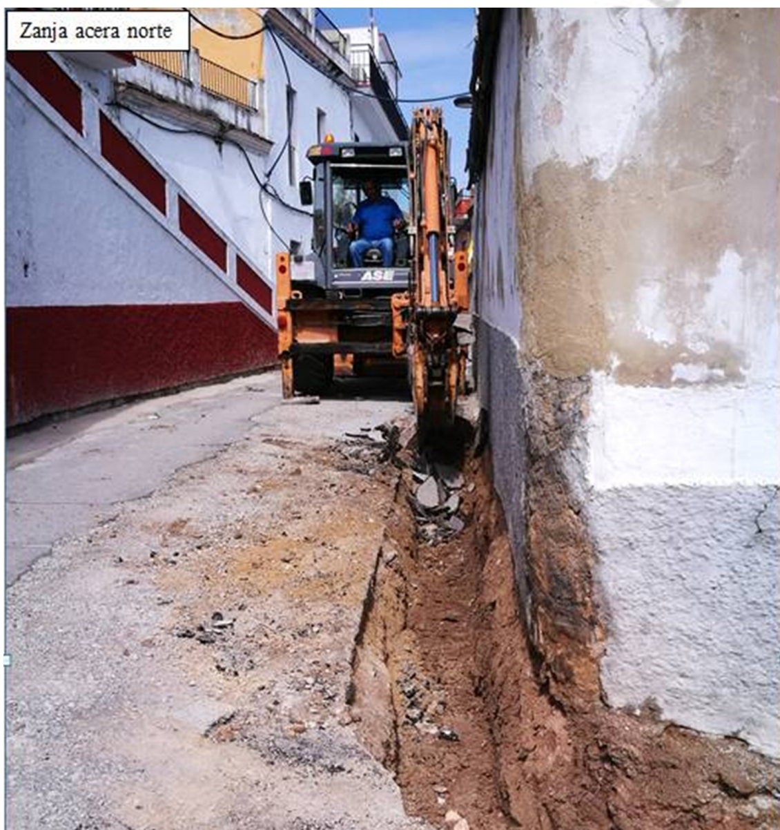
Fig. 11. C/ Calvario Bajo vista sustitución red de agua acera norte
