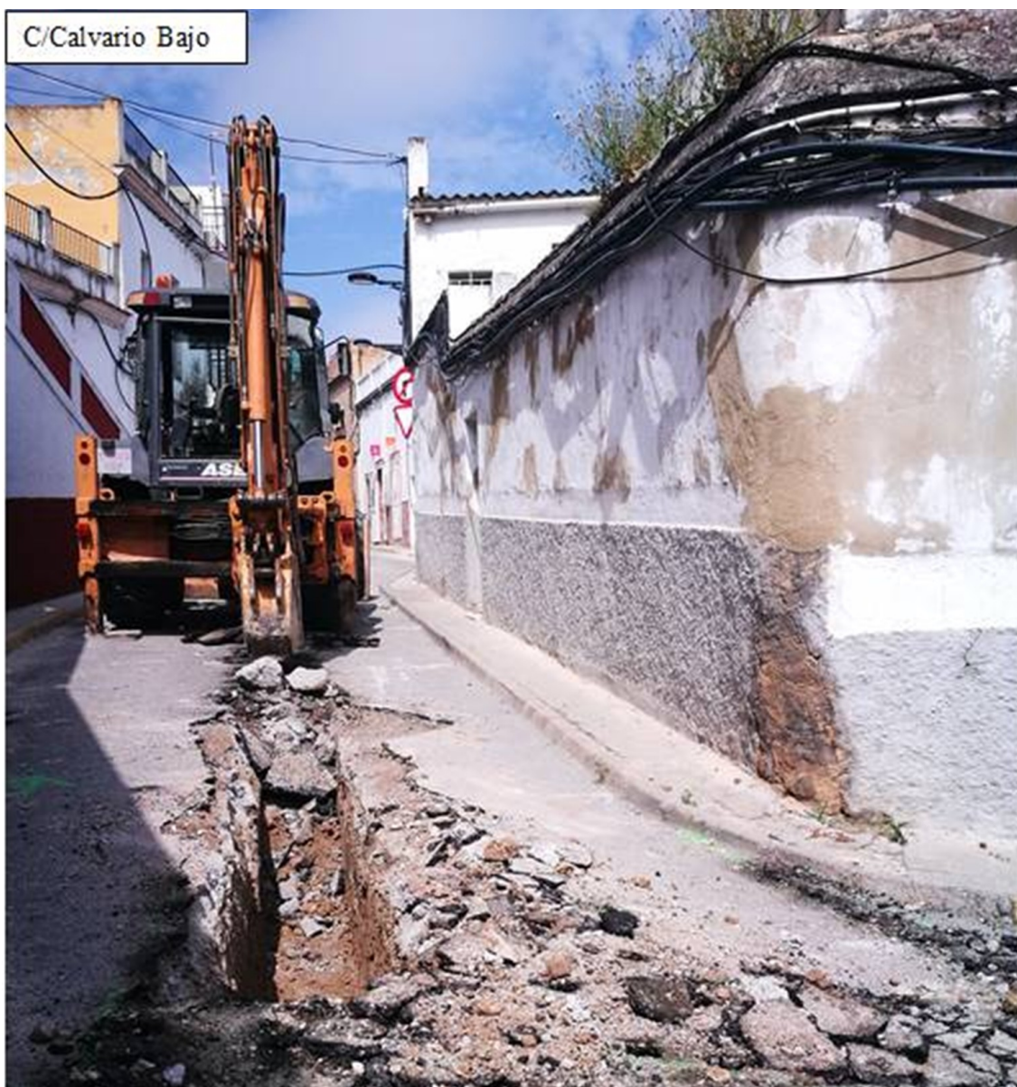
Fig. 10. C/ Calvario Bajo vista sustitución red saneamiento
