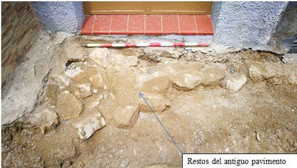
Fig. 12. C/ Calvario Detalle posibles restos de pavimento
