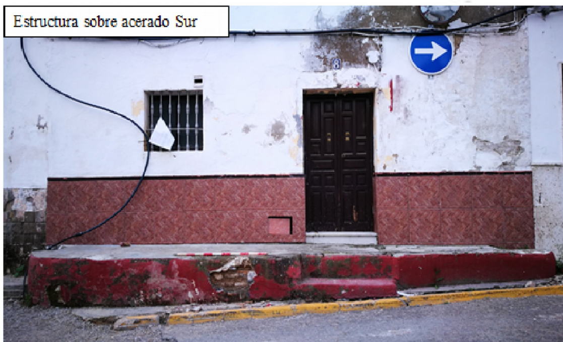
Fig. 15. C/ Calvario Bajo vista de acceso a vivienda para salvar desnivel
