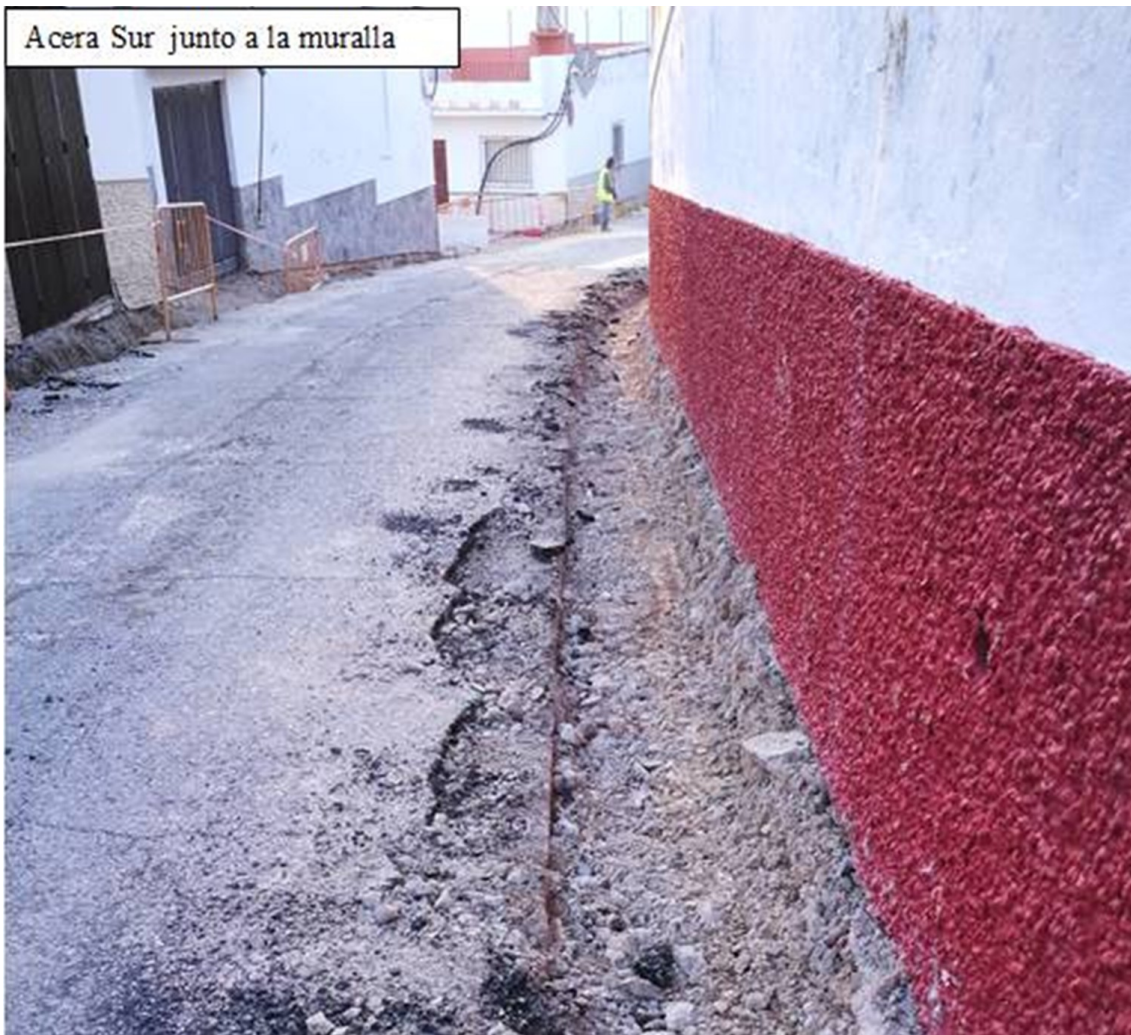
Fig. 14. C/ Calvario Bajo vista desmonte acerado sur
