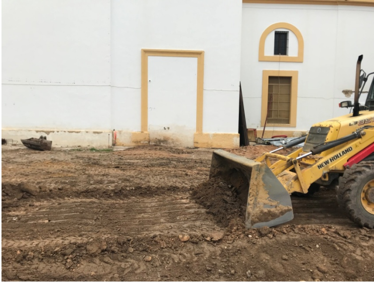
Figura 5. Rebaje general de la parcela.
