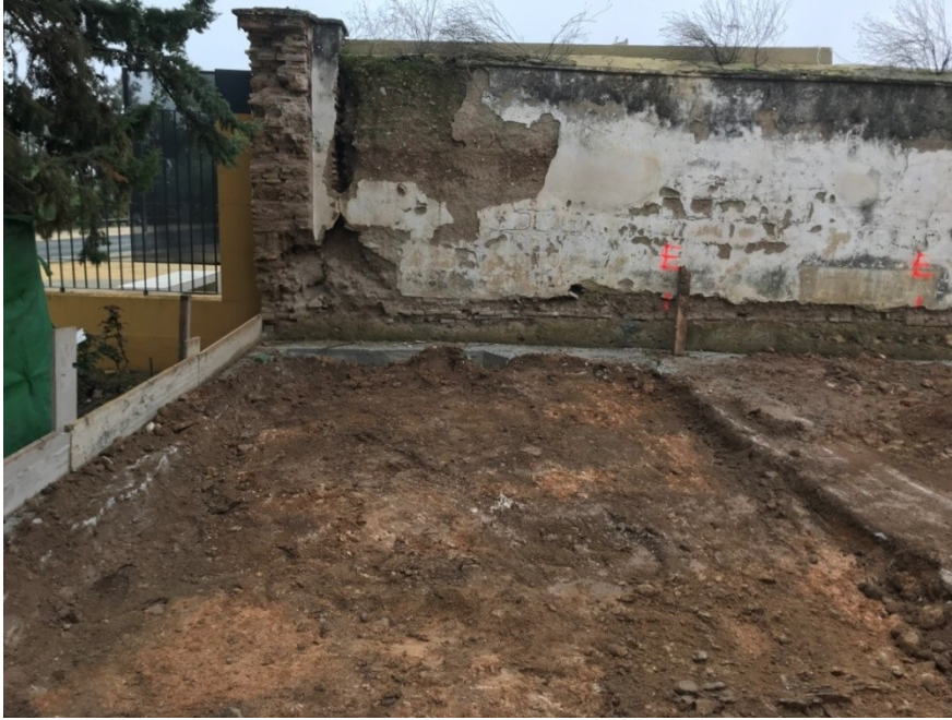
Figuras 7 y 8. Desarrollo de los trabajos con la ejecución de las zanjas de cimentación.
