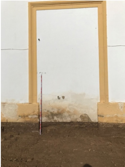
Figura 6. Rebaje general de la parcela, alcanzando la cota histórica de construcción de la iglesia (siglo XIX).
