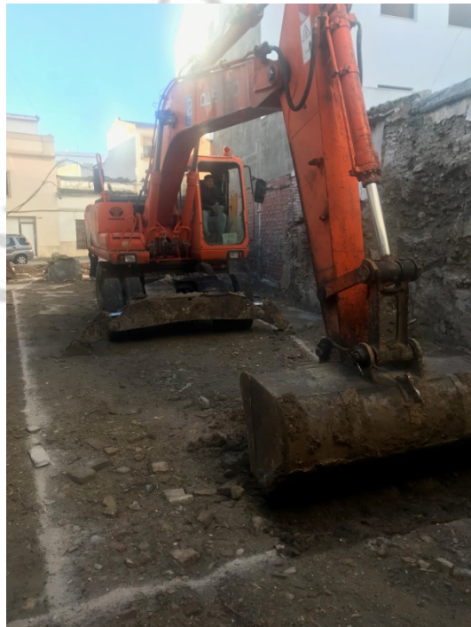
Fig. 2. Inicio de los trabajos de rebaje en la parcela.
