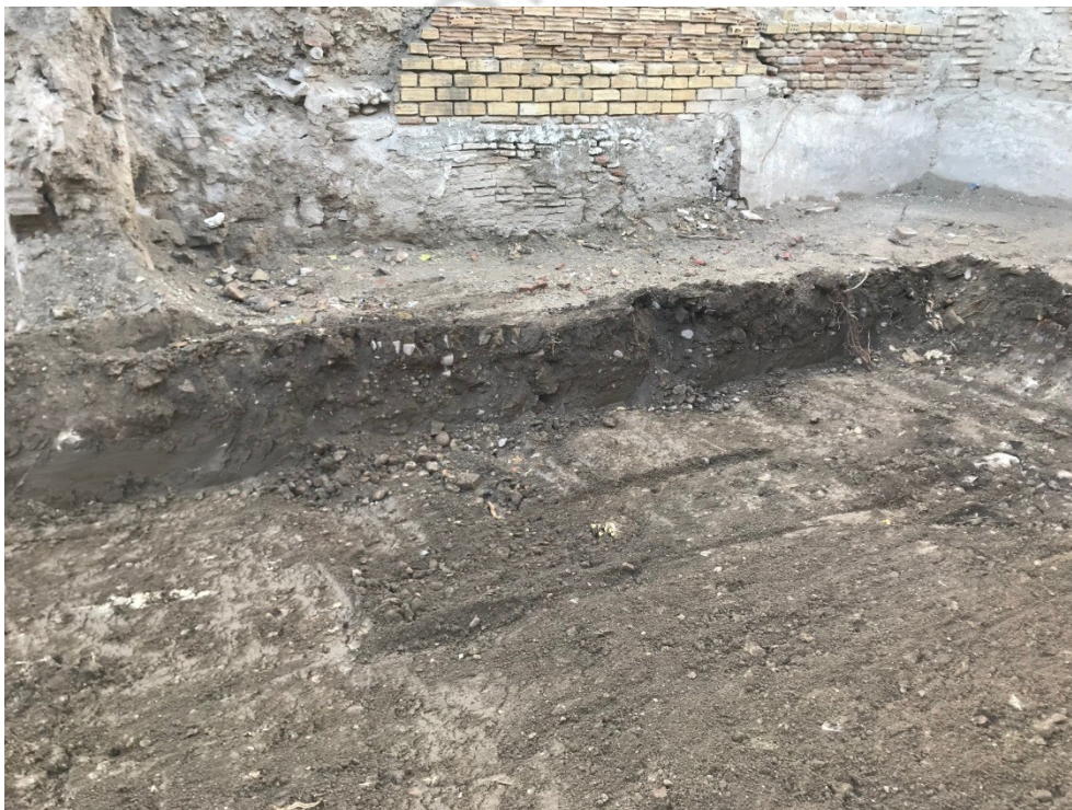
Fig. 5. Perfiles resultantes de los trabajos de rebaje en la parcela.
