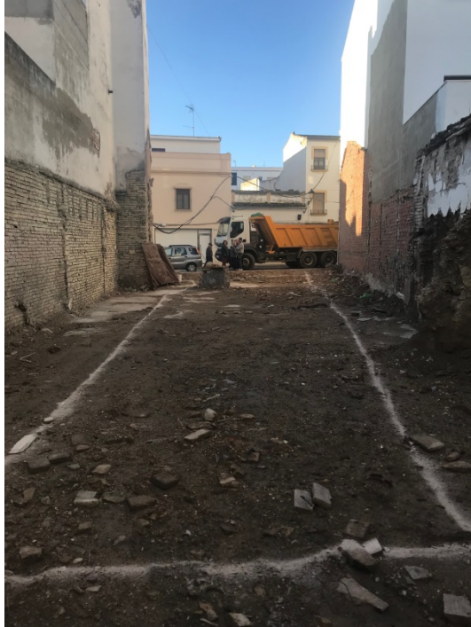
Fig. 1. Estado de la parcela antes del inicio de los trabajos de rebaje en la parcela.
