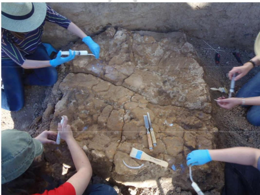
**Figura 21.** Consolidación de la superficie de adobe con inyecciones de resinas acrílicas
