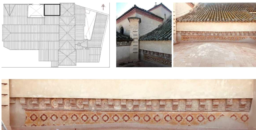
FIGURA 2. Actuaciones sobre la cubierta de la Capilla del Sagrario.
