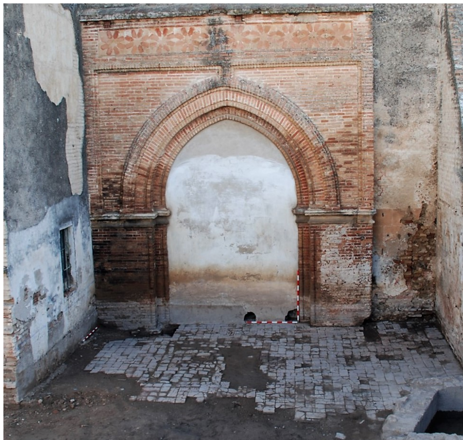
FIGURA 5. Pavimento UE 3 asociado a la portada Oeste de la iglesia.
