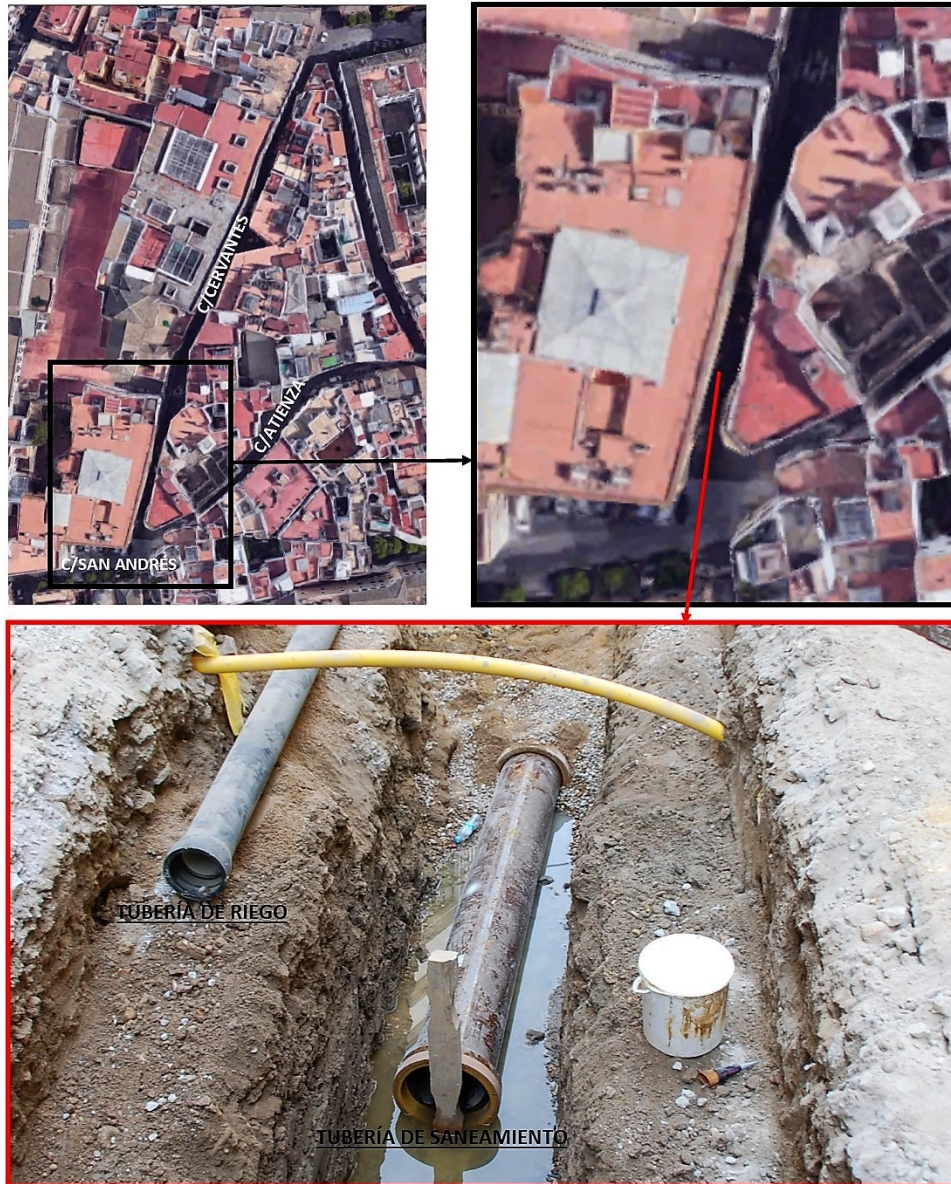
FIGURA 4. Ubicación del tramo Sur de calle Cervantes e imagen significativa del proceso de obras.
