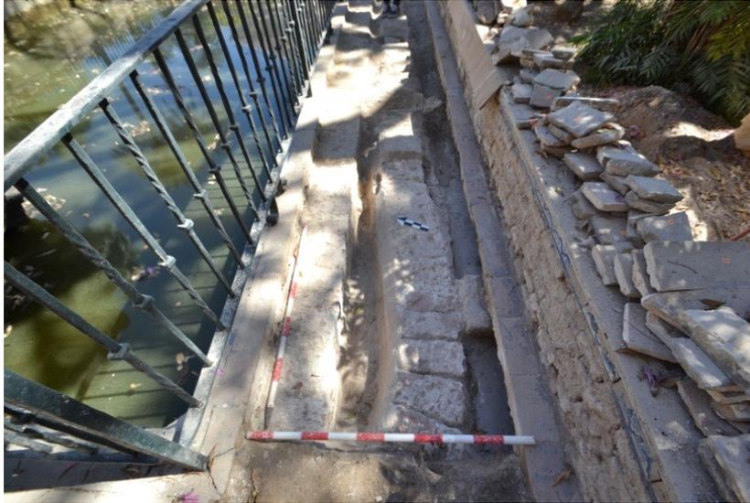
Conducción bajo el andén sur. En este sector existía un suelo de argamasa junto al muro (derecha) que permitía evacuar excedentes a la huerta a través de diferentes canalillos pasantes bajo este.
