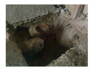
Vista del sondeo una vez alcanzada la cota de obra proyectada. Se puede observar la presencia de una tubería de hormigón de época actual (TB-008).
