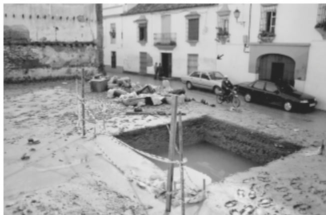
LAM. II. Situación de la excavación tras la inundación; obsérvese marcado con una flecha en la pared, la altura a que llegaron las aguas.
