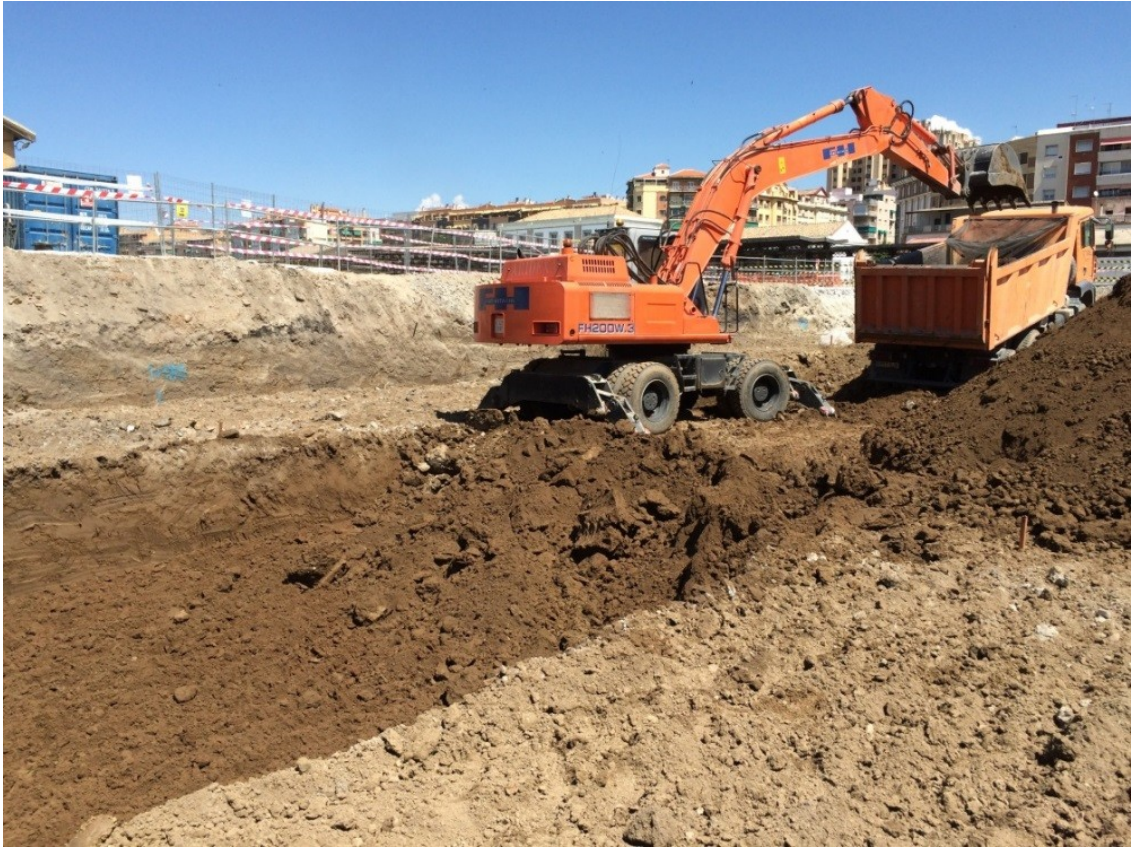
FIG. 12: EXCAVACIÓN EN EL SEGUNDO NIVEL Y DETALLE DEL PERFIL DE LIMOS
