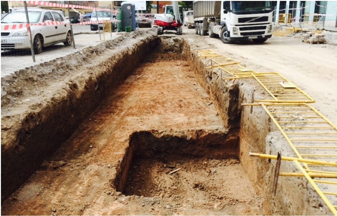
FIG.9: EXCAVACIÓN DE ZANJA PARA DESVIACIÓN DE SERVICIOS
