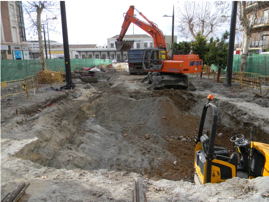
FIG. 14: TRABAJOS EN LA AVENIDA DE ANDALUCES
