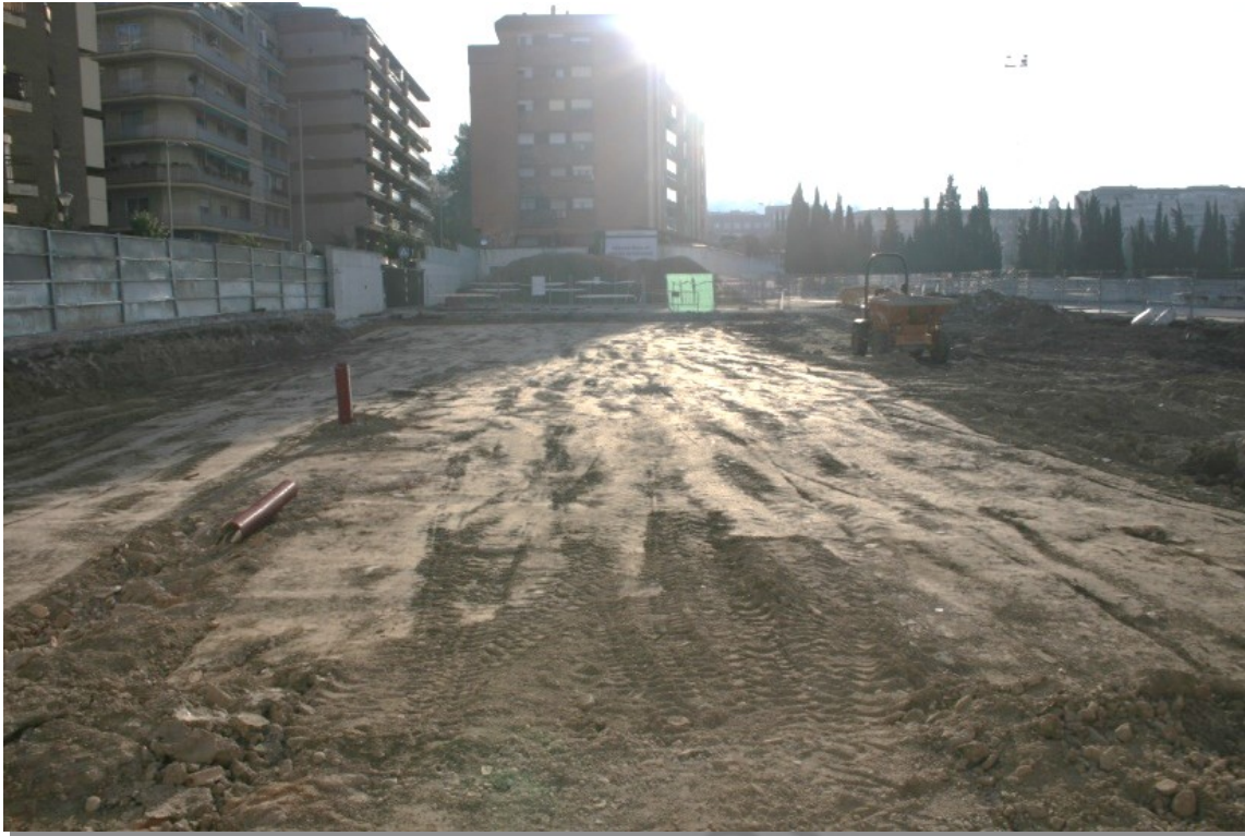
FIG. 1: ESTADO DE LA ZONA DE TRABAJO TRAS LAS DEMOLICIONES
