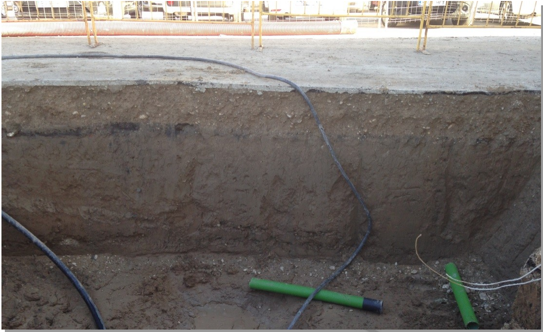
FIG. 5: DETALLE DE UNO DE LOS PERFILES DONDE SE APRECIA EL PAQUETE DE TIERRA VEGETAL BAJO EL RELLENO DEL ASFALTO
