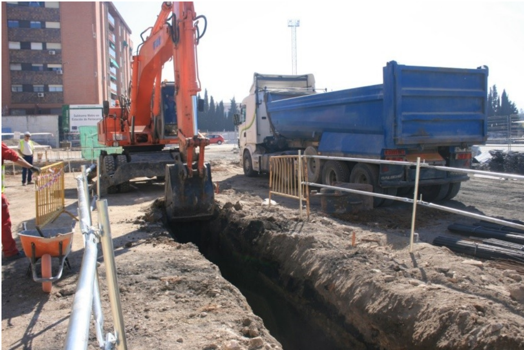
FIG. 7: TRABAJOS DE EXCAVACIÓN DE ZANJAS
