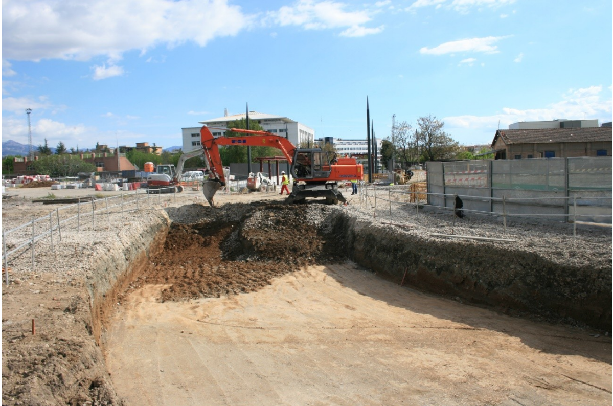
FIG. 15: VISTA GENERAL DE LOS TRABAJOS
