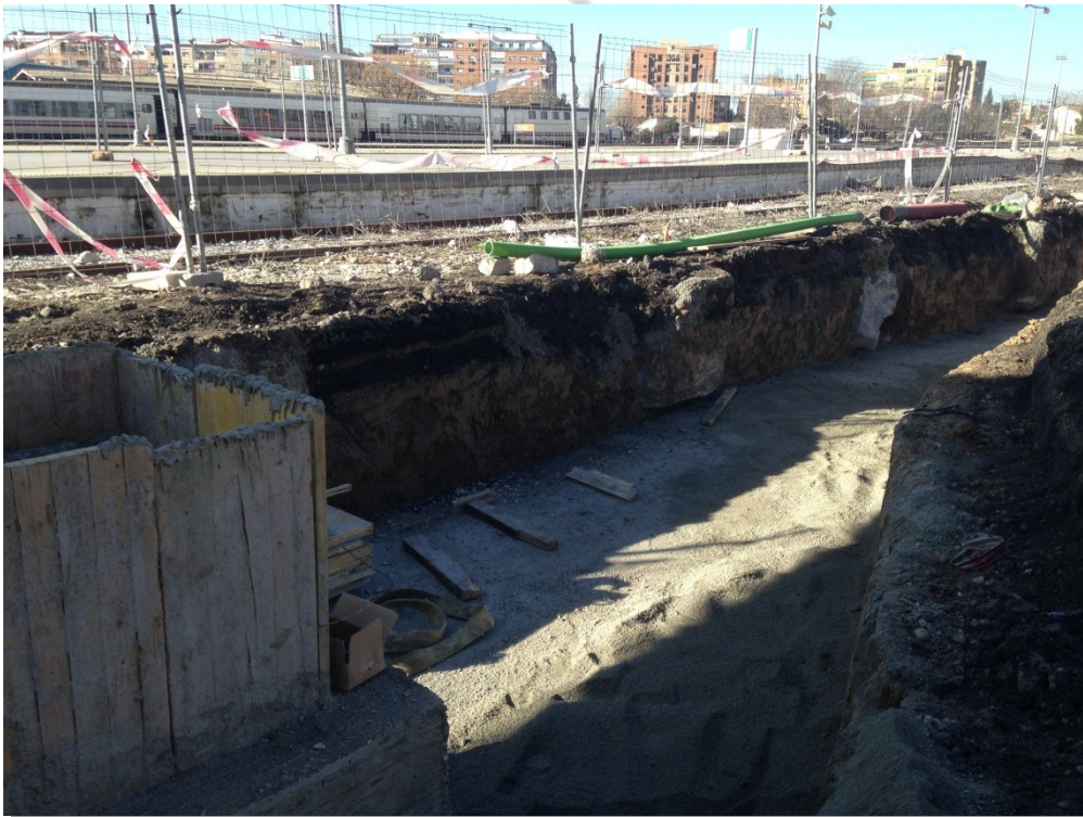
FIG. 4: ZANJA ABIERTA PARALELA A LAS VIAS
