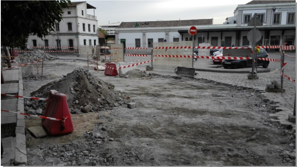
FIG 3: VISTA DE LA ZONA DE TRABAJO TRAS EL LEVANTAMIENTO DEL ADOQUINADO
