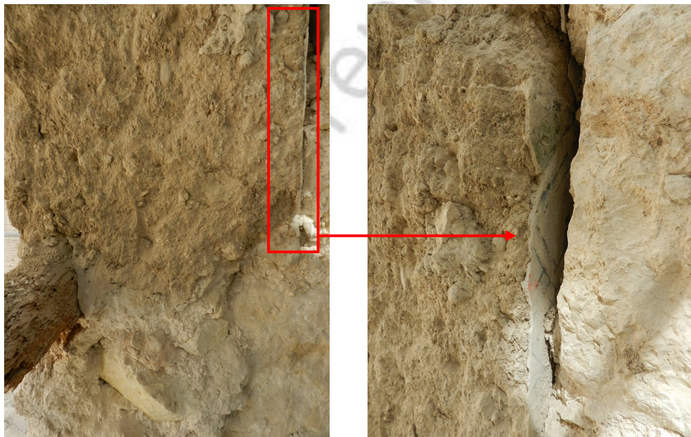
Detalle del cajón de tapial y ubicación del enlucido y las pinturas.
