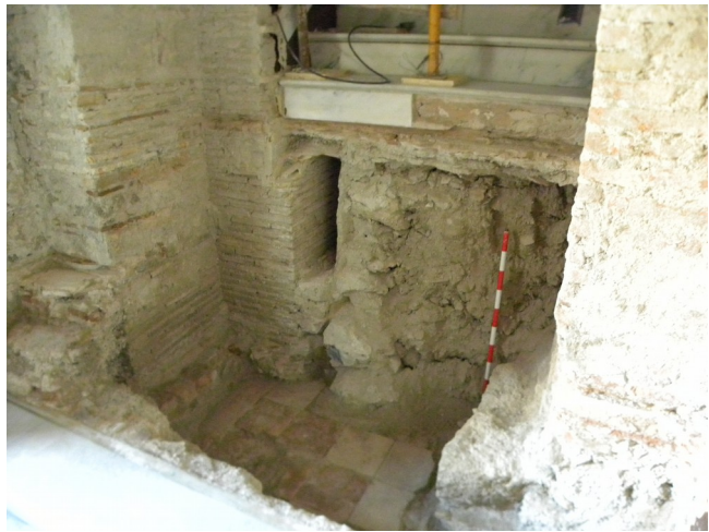
Vista general del hueco en el lateral SE de la Torre
