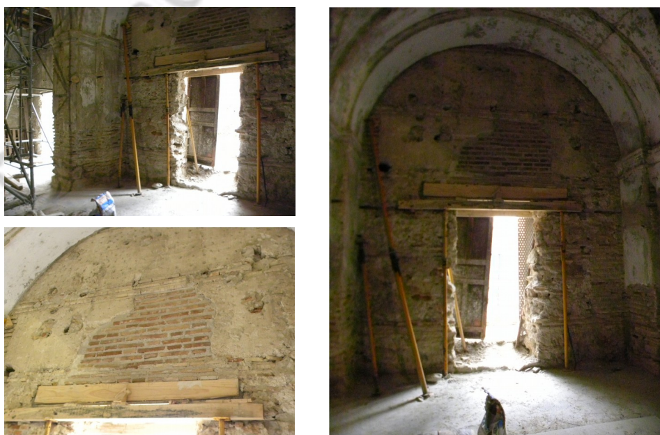
Vista frontal del alzado Noroeste tras la apertura del hueco y detalle de la reparación.
