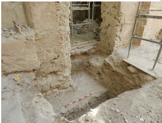
Cata realizada para la detección de la cimentación del Contrafuerte 2.
