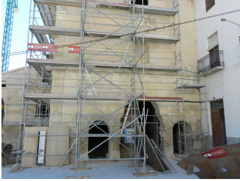
Apertura de huecos laterales en Fachada Principal. Vista desde el exterior(1) e interior (2).
