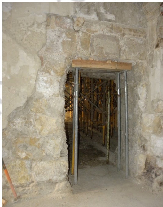
Vista frontal del hueco tras la apertura total.
