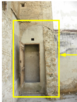
Huevo cegado nave central. Vista Exterior.
