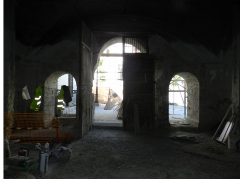
Apertura de huecos laterales en Fachada Principal. Vista desde el exterior(1) e interior (2).
