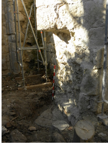
Estado del Contrafuerte 1 tras la excavación. Alzado destruido y detalle de la cimentación.
