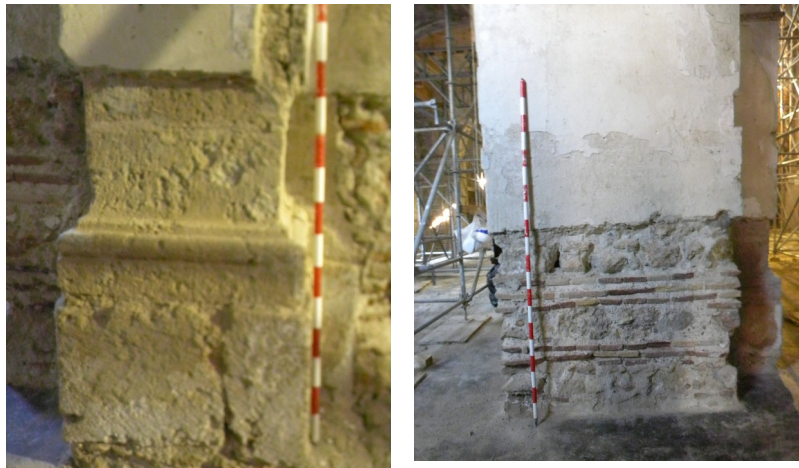
Vista de las zonas donde han sido eliminados los paramentos
