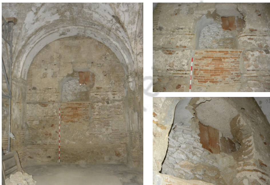
Vista frontal del alzado Noroeste tras la retirada del revestimiento y detalles del hueco.
