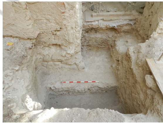
Cata realizada para la detección de la cimentación del Contrafuerte 2.
