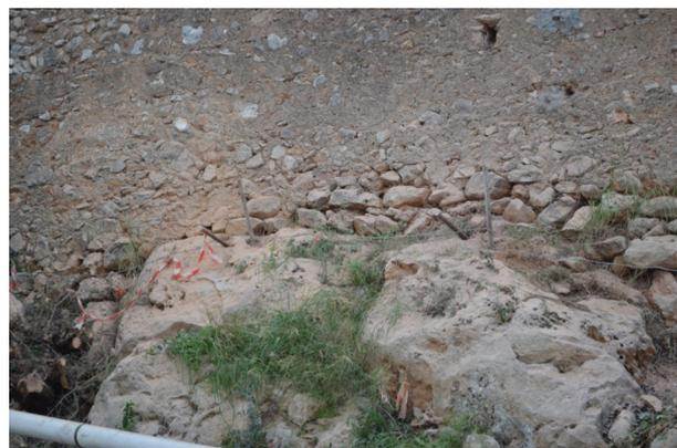
Lám. VI. Gunitado de refuerzo de la base del muro de cerramiento y talud.
