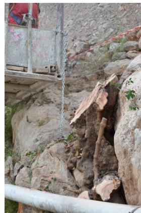
Lám. V. Trabajos de colocación de anclajes y de la malla metálica.
