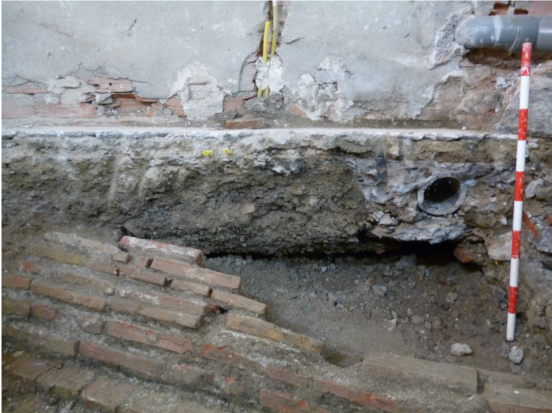
Fig.3 En primer término la Ue. 6, colector de aguas residuales con la bóveda cortada por la zapata del edificio. Al interior relleno de gravas Ue. 7.
