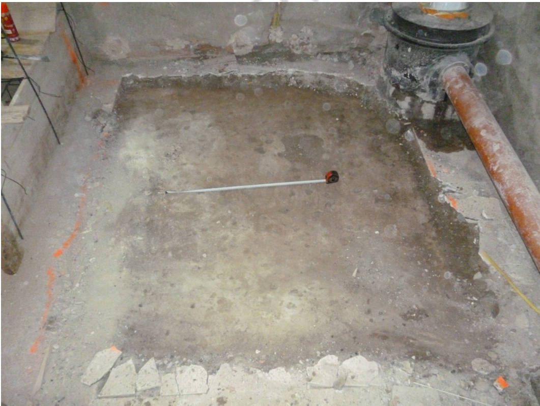
Fig. 2 Ue. 2 una vez desmontada parcialmente la Ue.1
