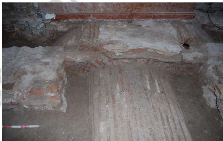
Imagen de la bóveda del pasillo de acceso a la cámara funeraria y arranque de la misma reparada con rasillas y cemento.
