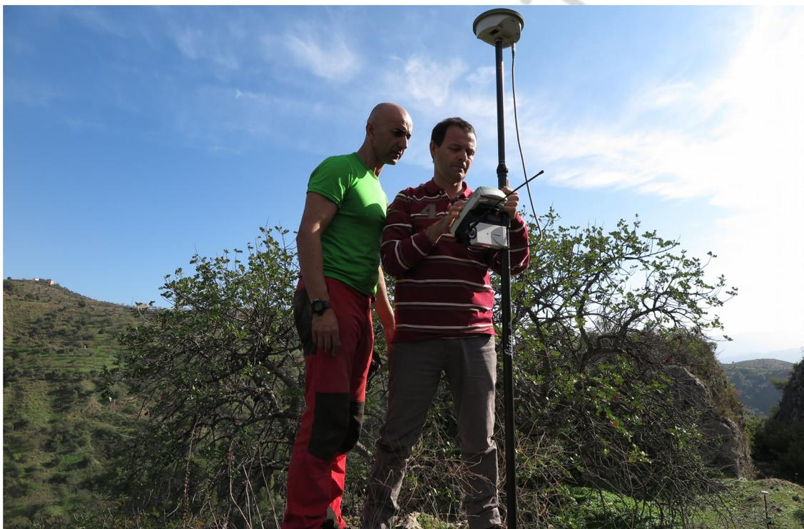
Figura 9. Estación GPS con corrección diferencial para la colocación de los puntos UTM.
