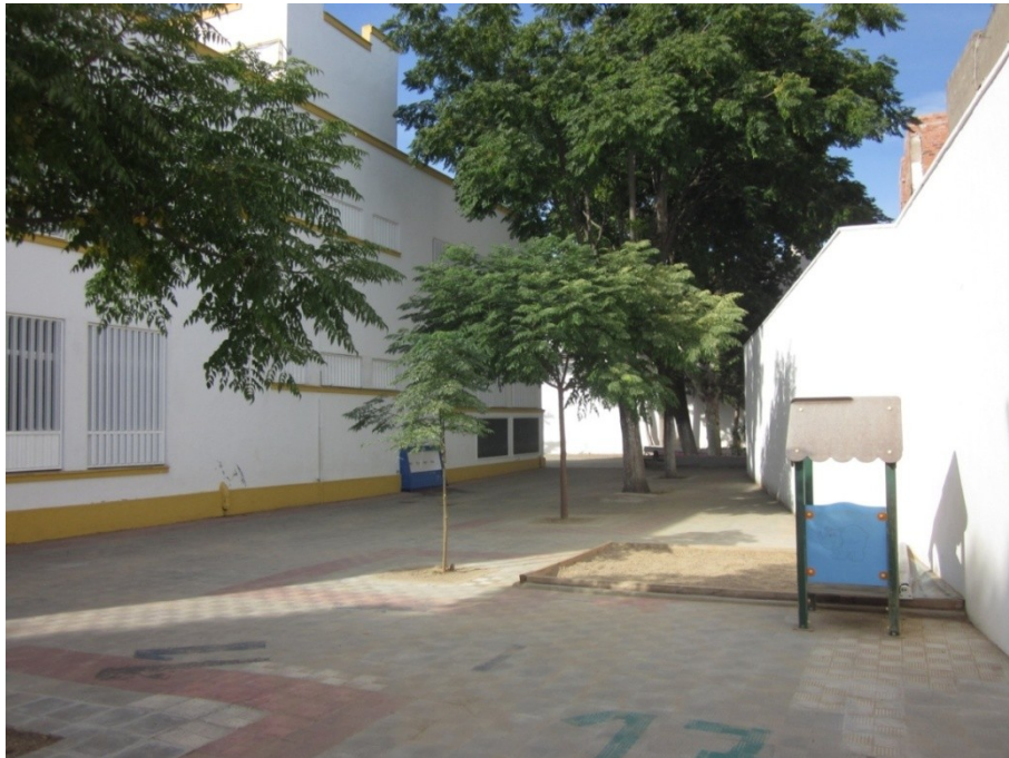
LAM. 2. Vista desde el este del área de intervención.
