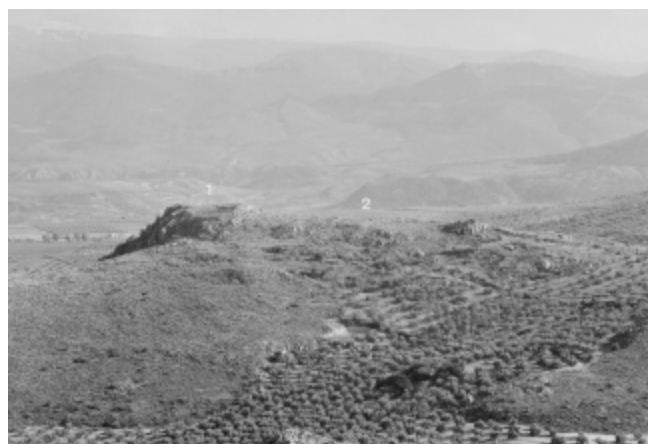
LAM. I. Hisn de la Majada de las Vacas. Vista desde el Norte. 1. Fortificación 2. Zona de hábitat.
