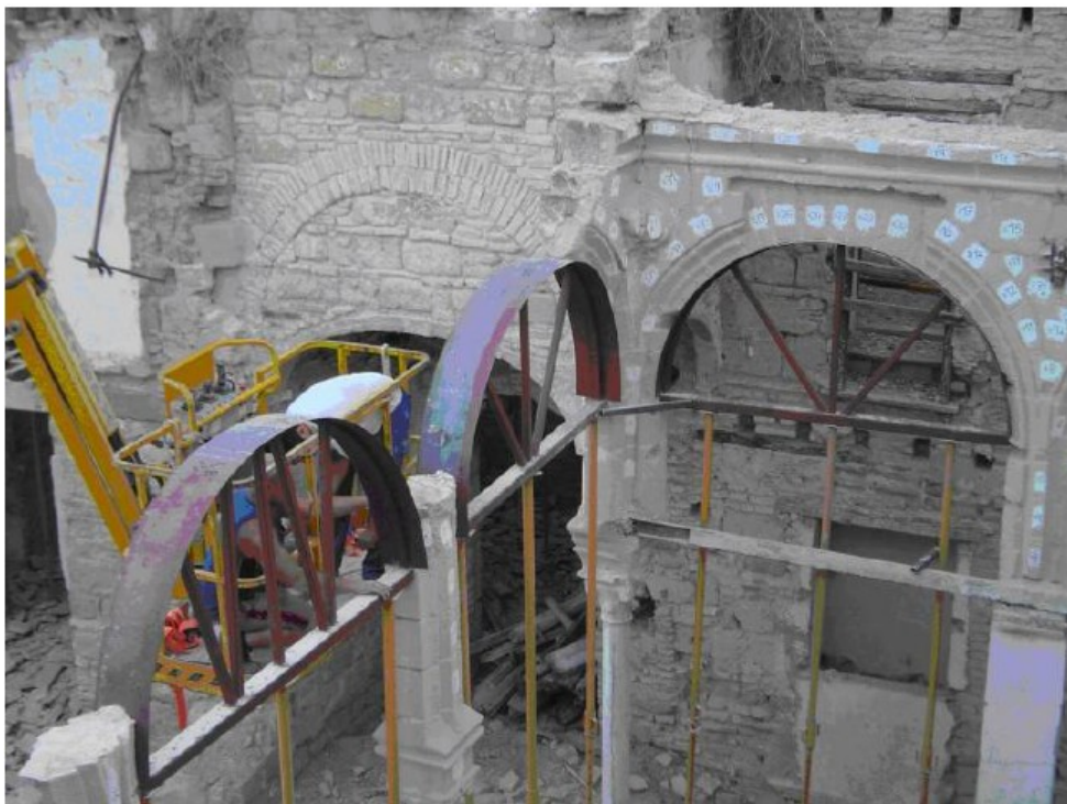
Lám. II. Desmonte de la arquería mudéjar
