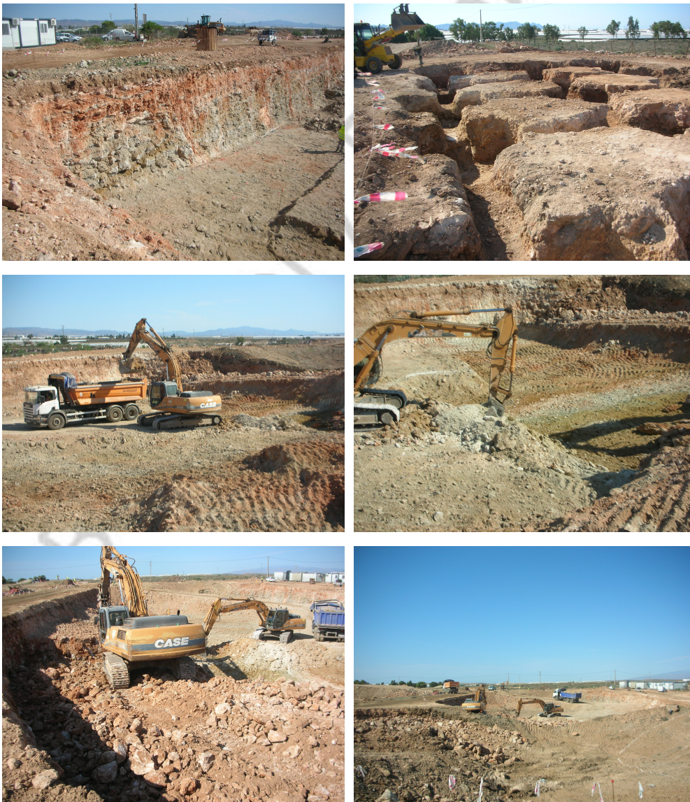
Proceso de excavación en la zona
