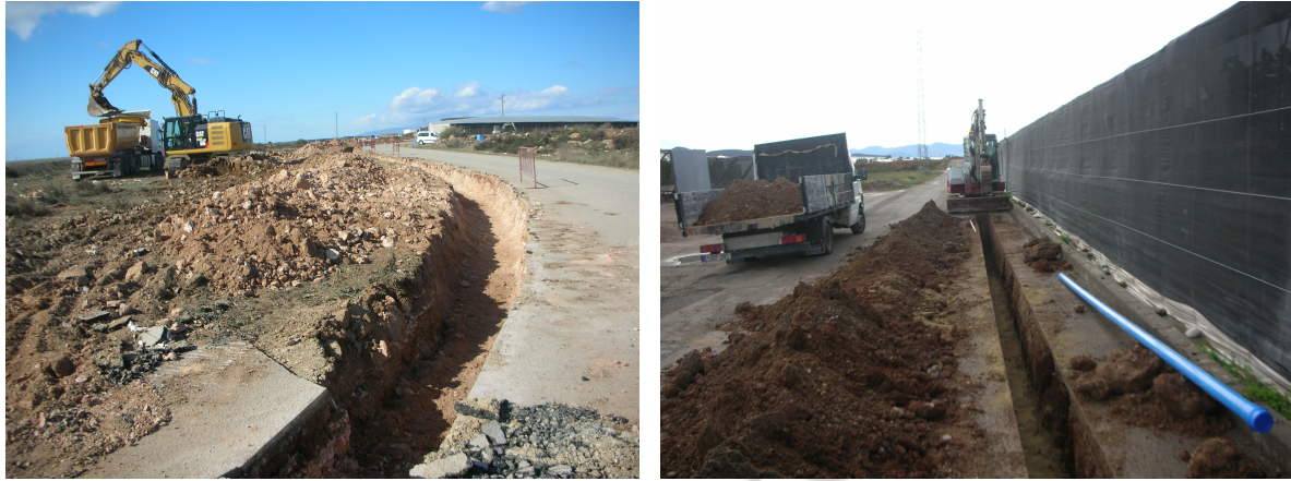
Apertura de la zanja para la conducción de agua
