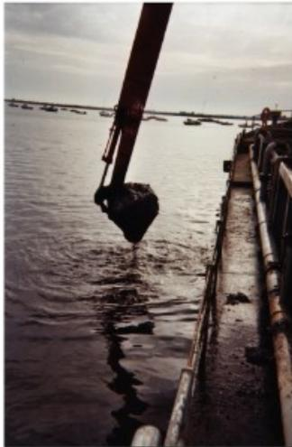
PROCESO DE DRAGADO CON EXCAVADORA
