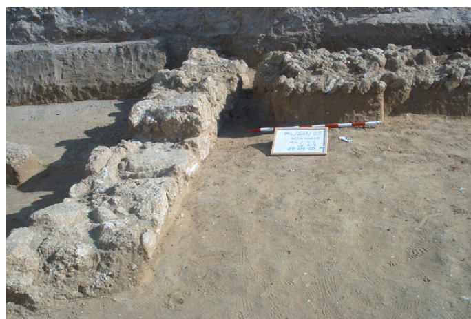
Figura 9. Murete de mampostería. Sector N.E.
