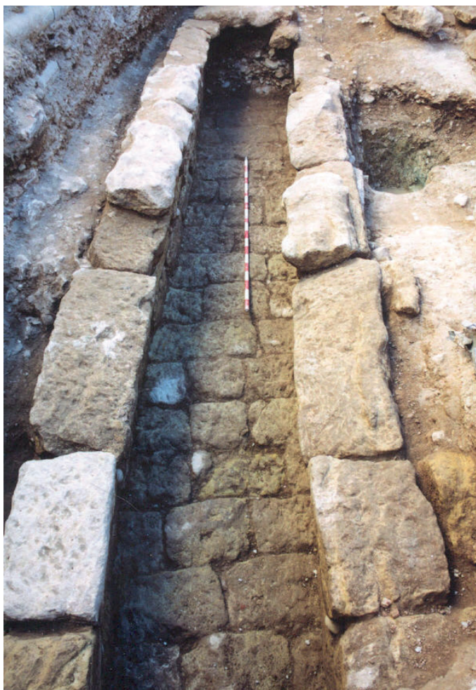
Lámina I. Canalización (UUEE 6, 9, 20). Corte 1.
