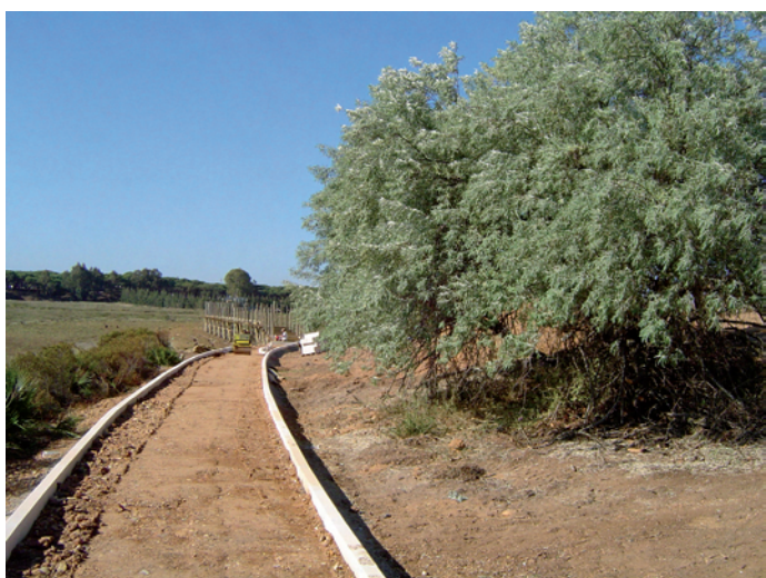
Lámina III. Relleno del carril-bici
