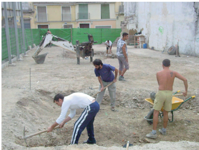
Lámina I. Situación del solar
