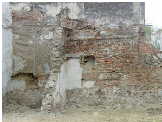
Lámina VI. Paramentos Medianeros en solar nº 5
