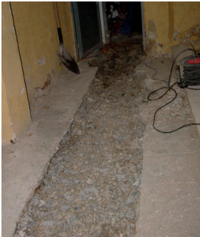
Lámina III. Zanja para saneamiento
