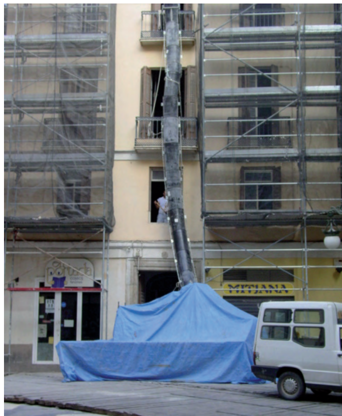
Lámina I. Obras de rehabilitación
