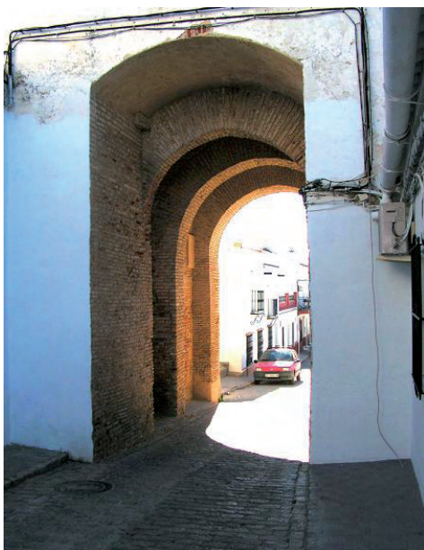
Lámina II. Vista intramuros del Tránsito 2 de la torre-puerta.
