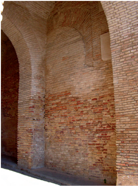
Lámina I. Vano interior del Tránsito 1 de la torre-puerta.
