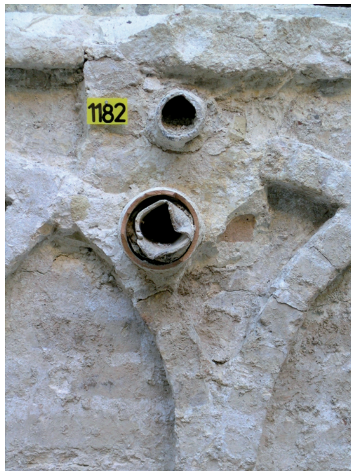
Lámina XIV. Detalle de los distintos atadores y tuberías de desagüe de las distintas fuentes que han ido sucediéndose entre 1584 y 1994.
