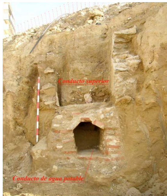
Lámina IV. S4. A escasos metros de S3 se descubre un nuevo tramo transversal a la canalización que mantiene la estructura y fábrica de la misma y, que está orientado hacia una alberca situada a unos metros de distancia
