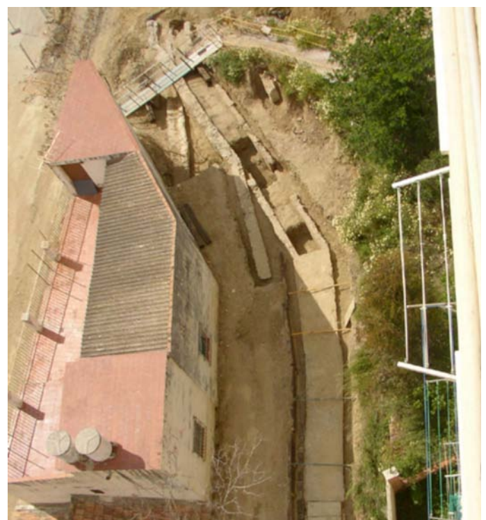
Lámina V. Perspectiva del cauce del canal de riego en la que se aprecia la cubierta de hormigón.
