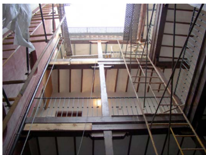
Lámina VI. Vista General del Inmueble
