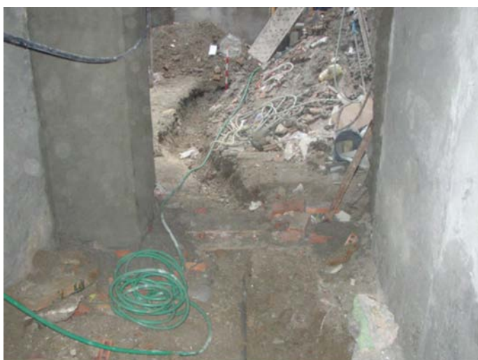
Lámina V. Vista general con arqueta contemporánea
