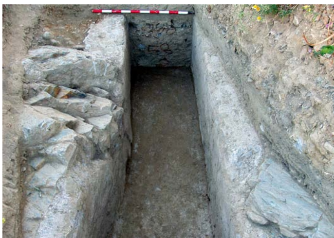
Figura 2. Afloramientos rocosos integrados en la obra del canal en la cata 6.
