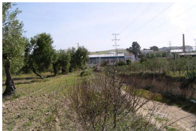
Lámina IV. Subestación de Morón de la Frontera
