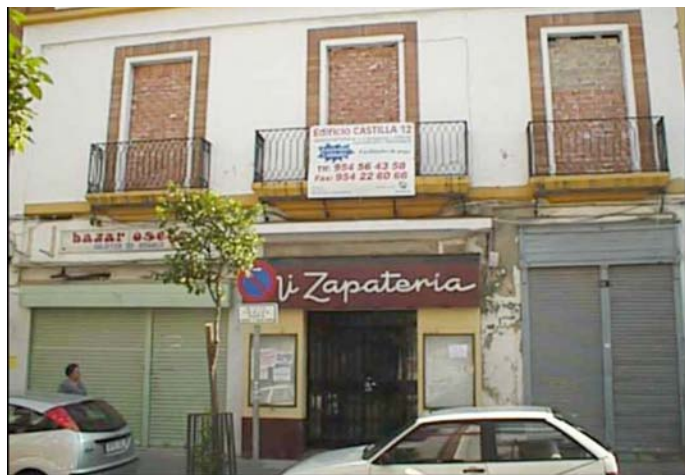
Lámina I. Fachada del nº 12 de la c/ Castilla.
