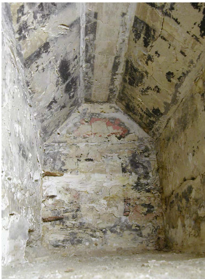
Lámina VIII. Detalle del interior del hueco en el que se encontraba encerrada la arqueta con los restos óseos del cardenal. Se observa claramente la impronta que la decoración pictórica sobre la madera de la caja dejó en el mortero aún fresco.
