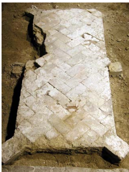
Lámina VII. Restos de la solería original del nuevo edificio gótico conservados bajo el monumento funerario del Cardenal Cervantes.
