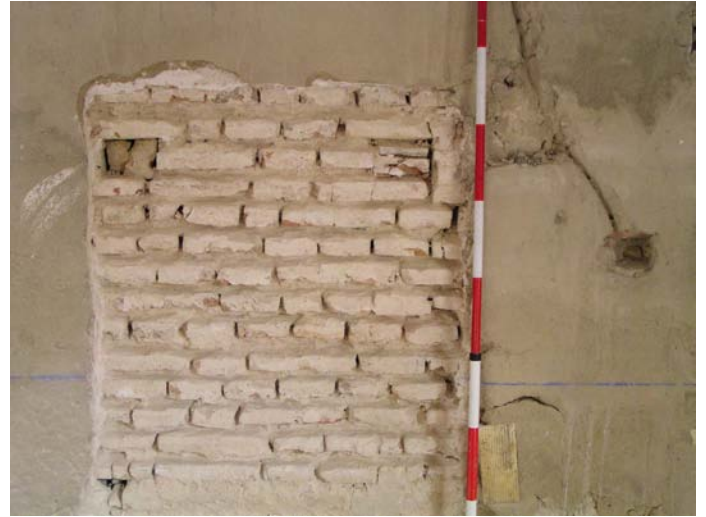
Lámina VI. Cata paramental en el muro P-3.
