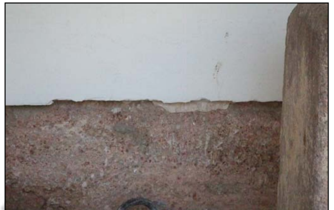
Muro del patio
