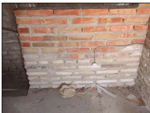
Situación antes de la restauración
