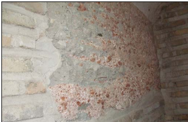
Restos de tapial en planta baja del alminar
