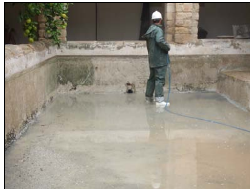
Limpieza con agua a presión
