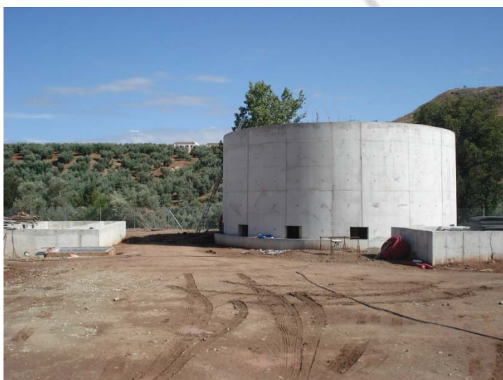
Lám. 9.- Detalle Estado final de las obras. Pozo de Gruesos. S-N.
