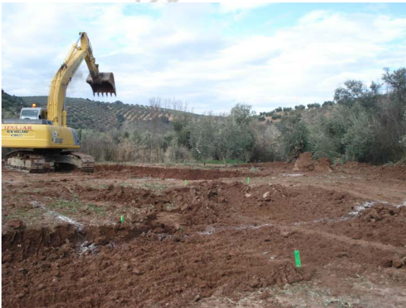
Lám. 3.- Replanteo de estructuras SE-NW.
