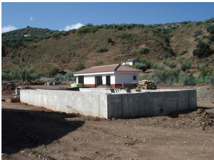
Lám. 8.- Detalle Estado final de las obras. Tanque Imhoff. N-S.
