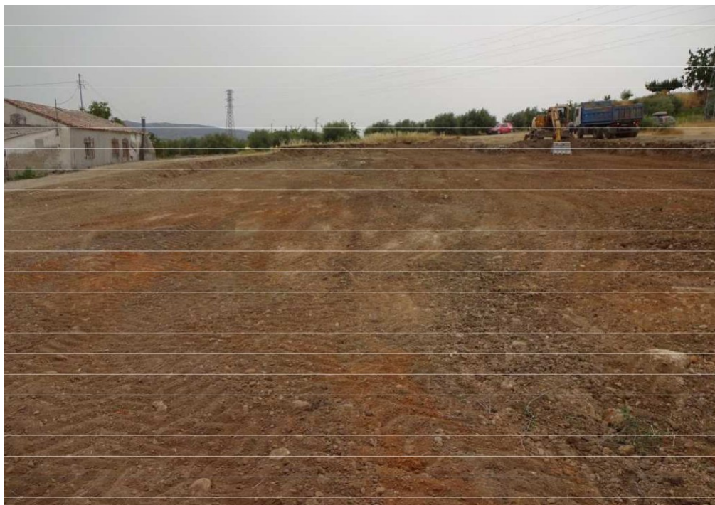
Lám. 3. Imagen general de la zona de trabajo una vez terminada la intervención.
