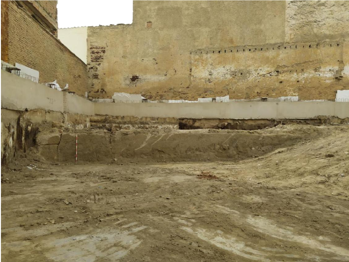
Lámina 1. Vista de la estructura desde su interior
