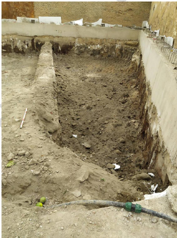
Lámina 4. Muro de la estructura y zona exterior
