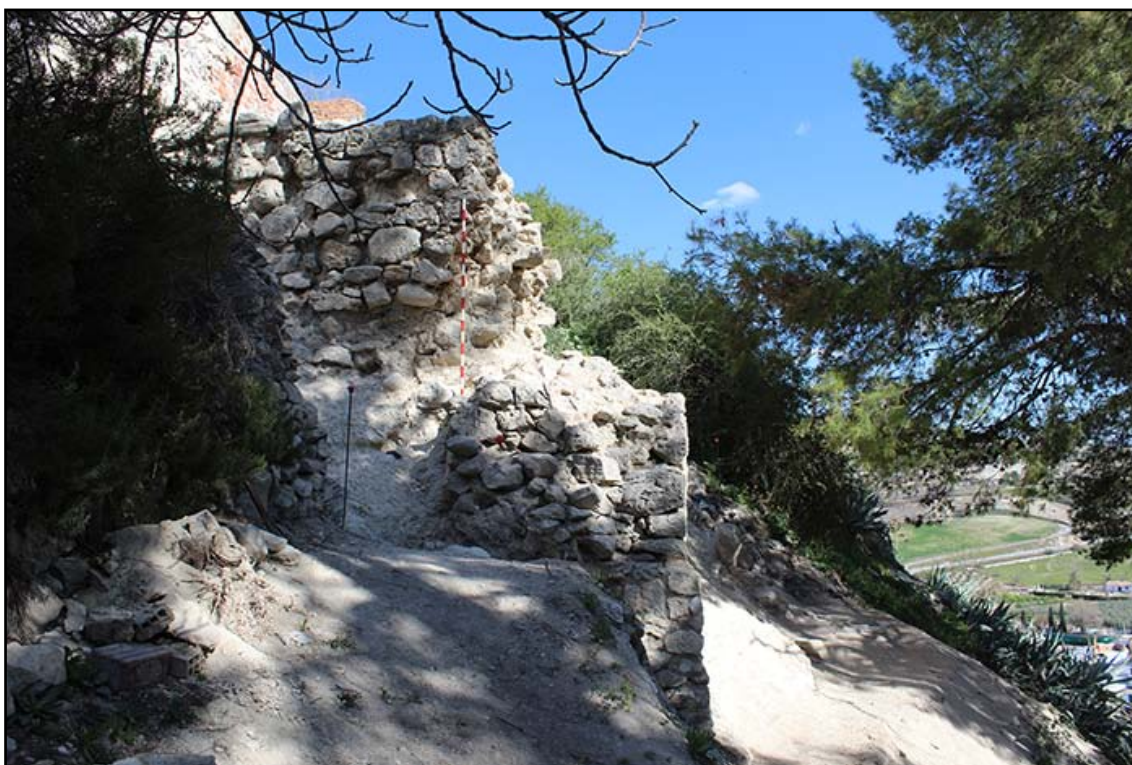
Lámina XX. Sondeo 5. Vista del lateral O de la torre desde el SO.
