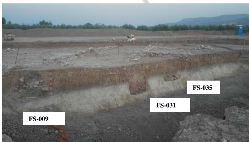
Vista del perfil sur antes y después de su saneamiento y perfilado manual.
