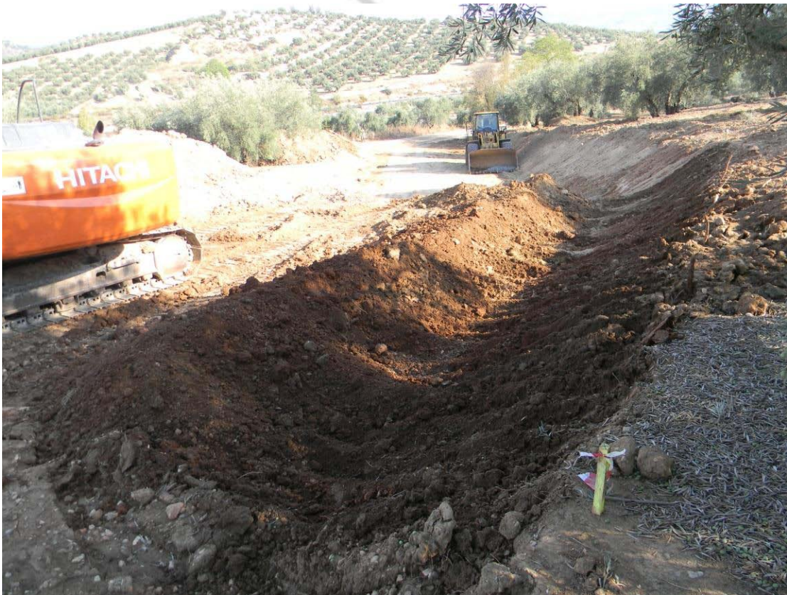
Desmante reposición carretera A-4153
