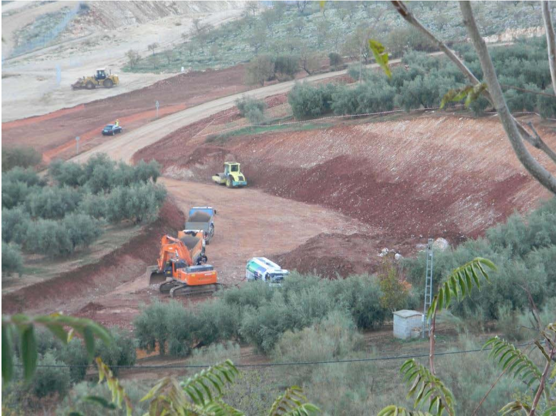
Camino conexión Oeste 1 Paso superior 6+344
