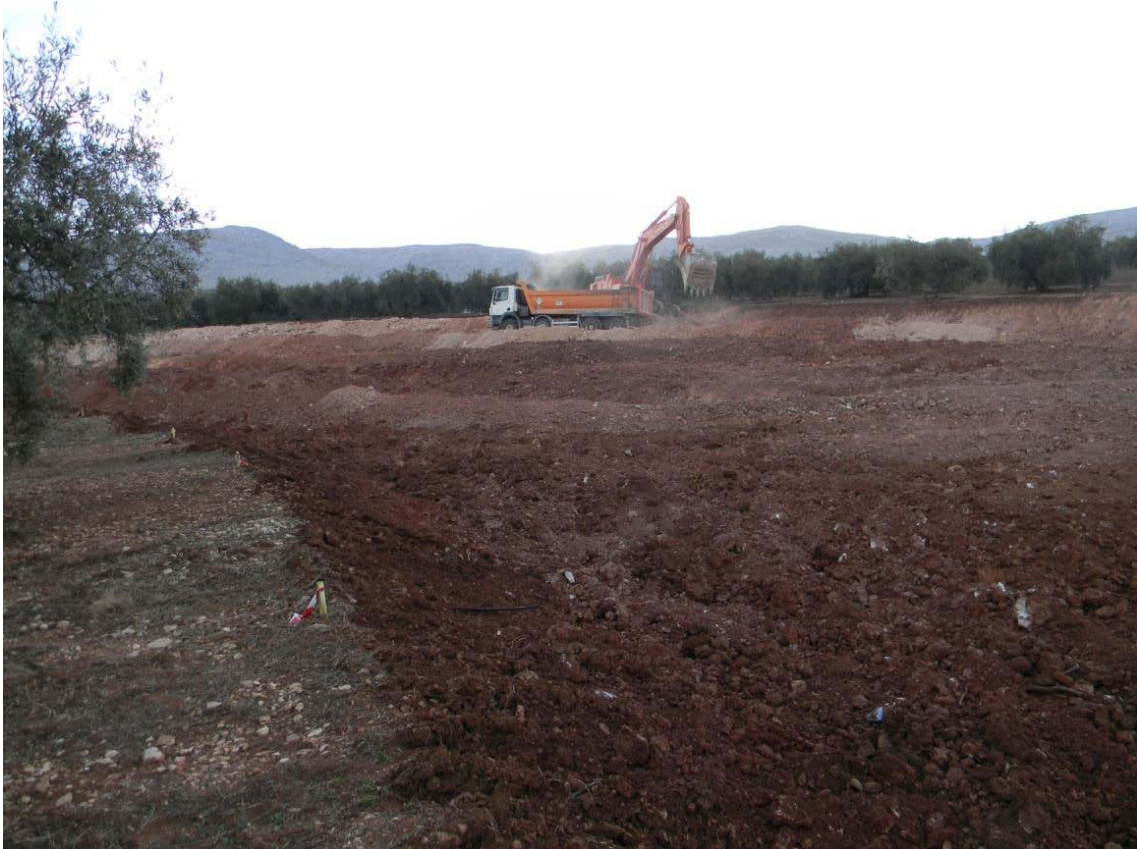
Camino conexión Oeste 1 Paso superior 6+344
