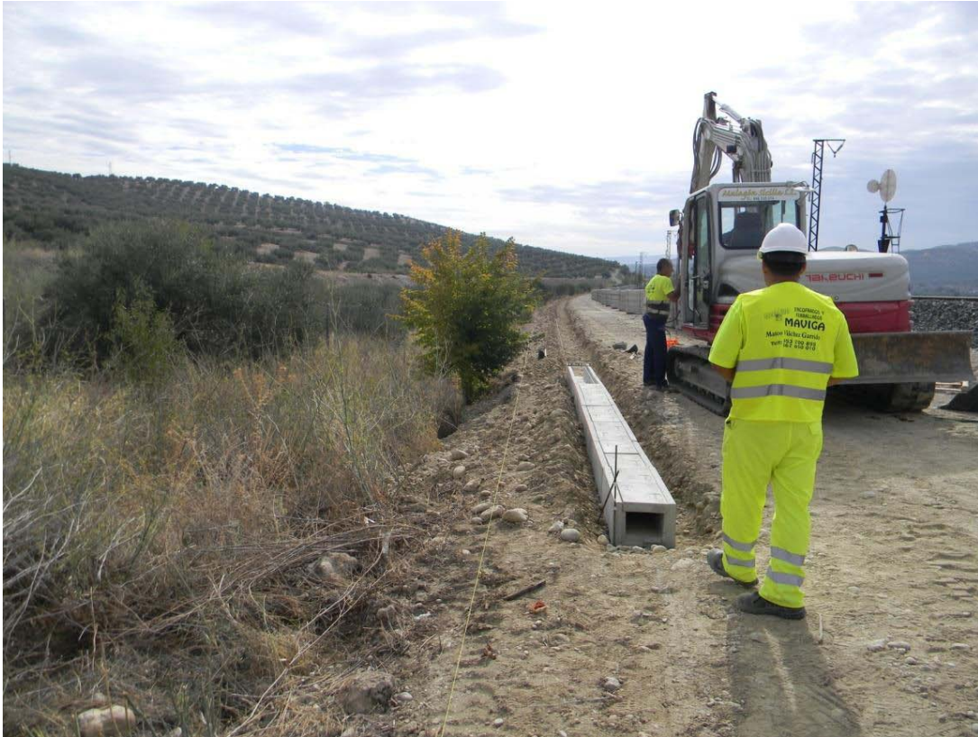
Zanja para servicios en plataforma desde P.K. 12+000
