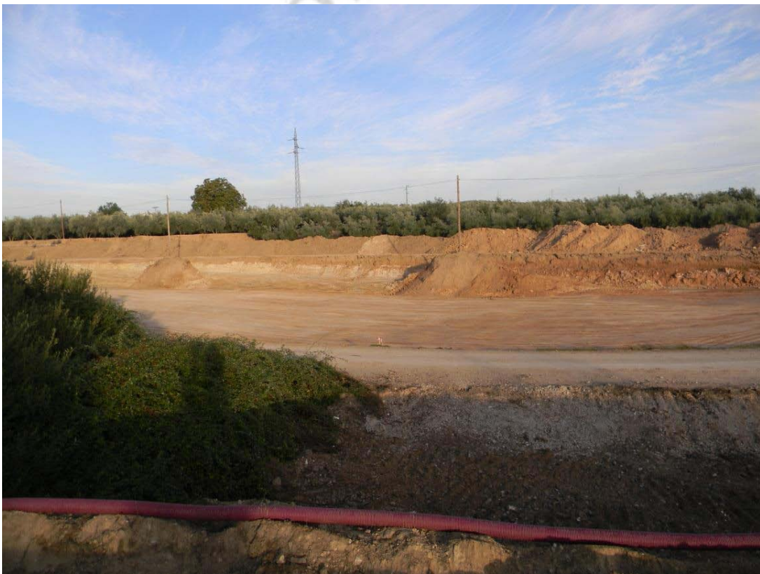
Camino conexión Oeste 1 Paso superior 6+344
