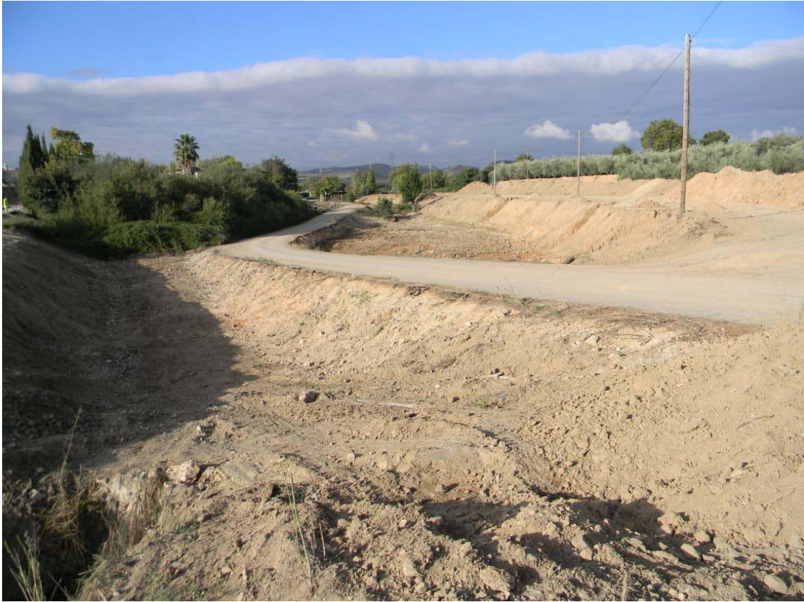
Camino conexión Oeste 1 Paso superior 6+344
