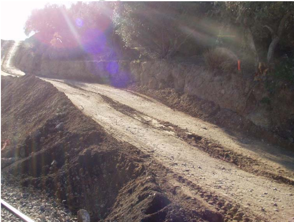
También se realizan los trabajos de seguimiento en el desmonte 27 :
