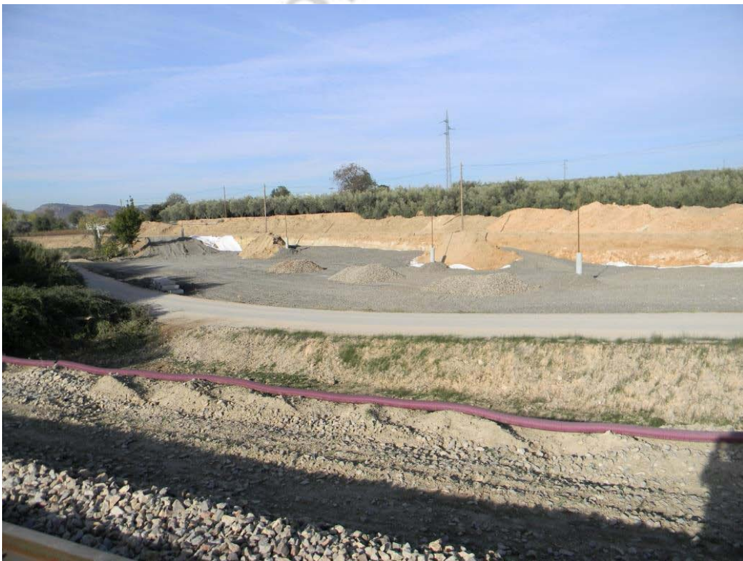
Camino conexión Oeste 1 Paso superior 6+344
