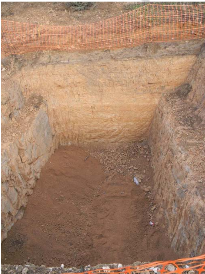
Reposición de servicios en Apeadero de Riofrío
