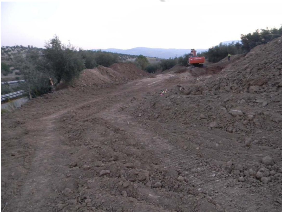
Desmante reposición carretera A-4153
