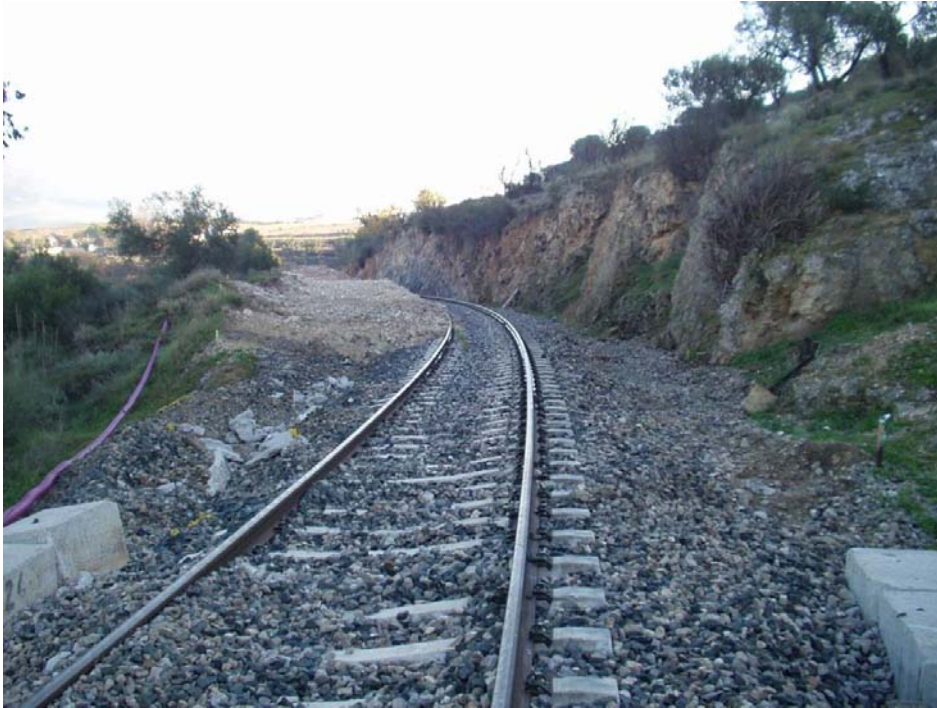
Trabajos en desmontes 13 y 14
