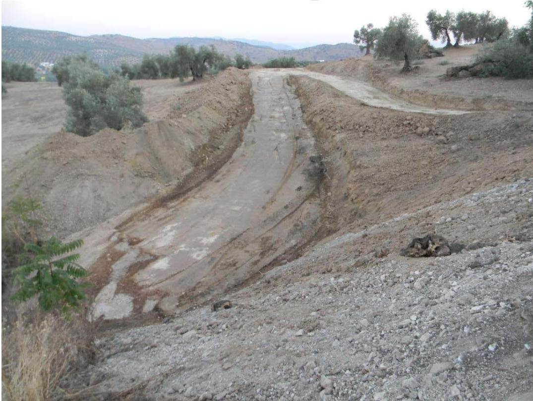
Desmonte reposición carretera A-4153
