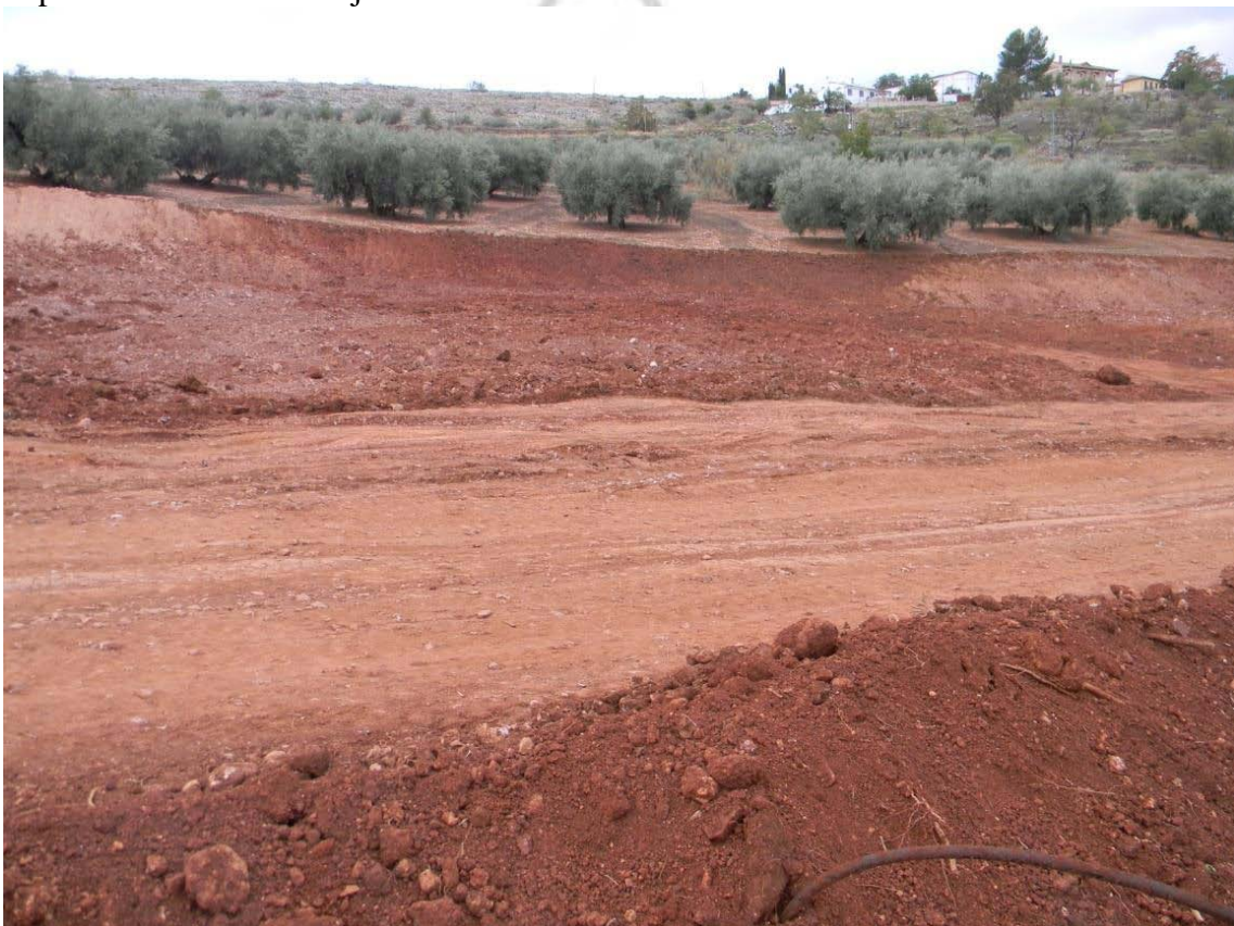
Reposición Carretera Atajea
