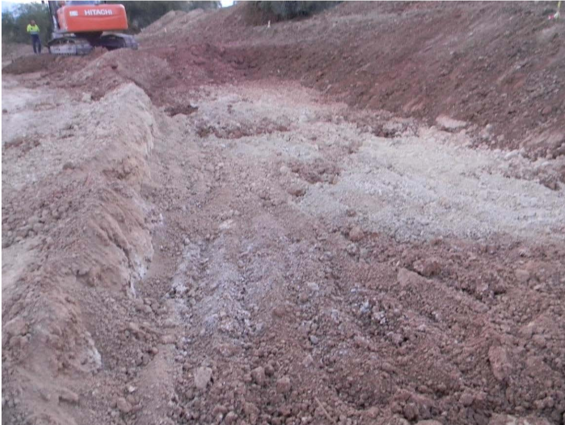
Detalle desmonte reposición carretera A-4153
