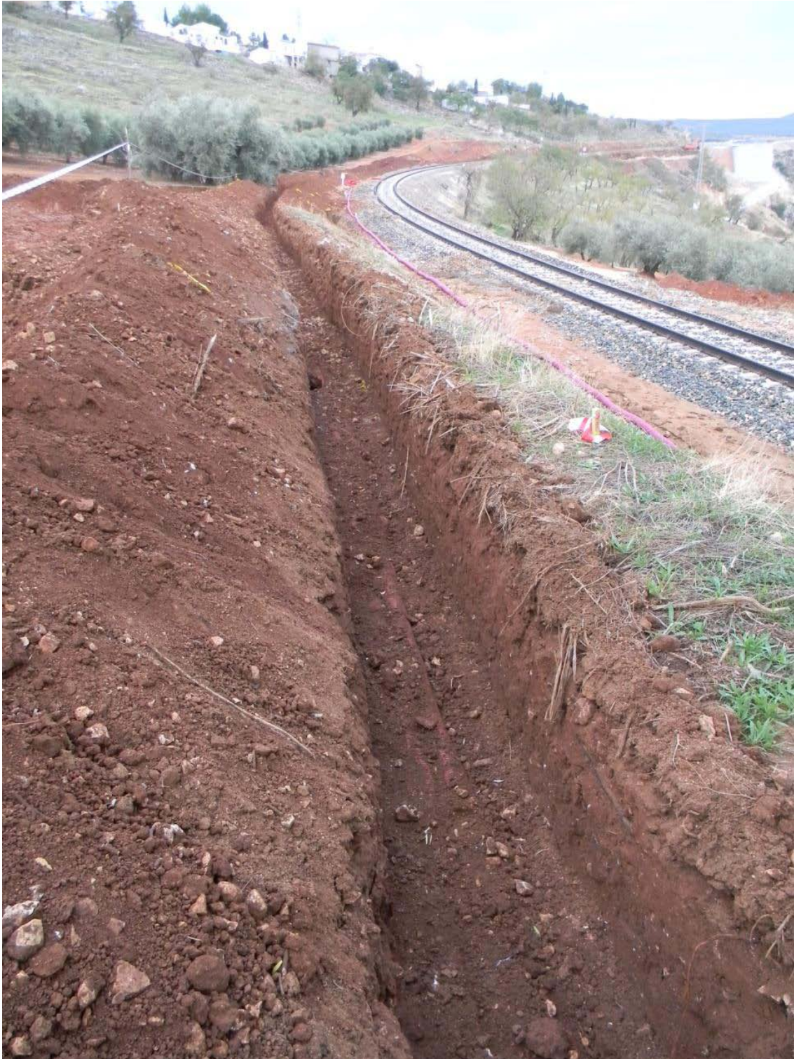
Zanja para reposición de servicios desde P.K. 1+600
