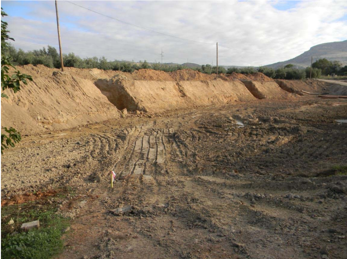
Camino conexión Oeste 1 Paso superior 6+344
