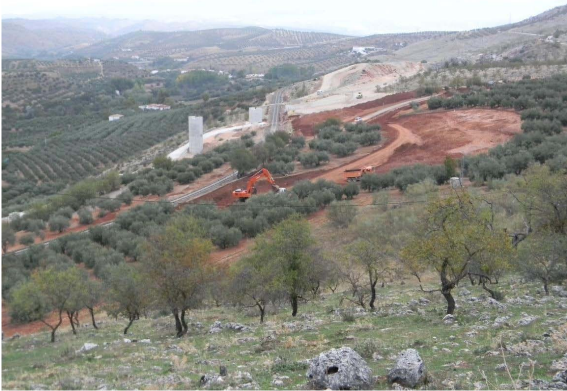
Reposición Carretera Atajea
