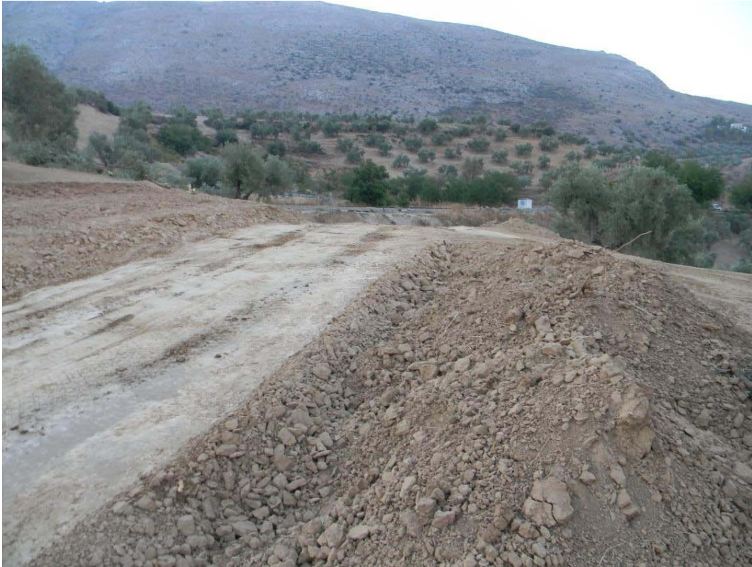
Desmonte reposición carretera A-4153
