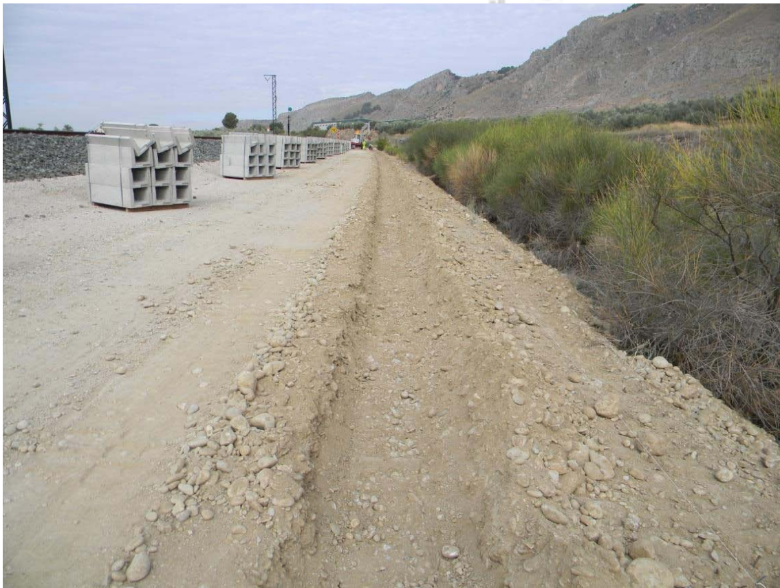
Zanja para servicios en plataforma desde P.K. 12+000
