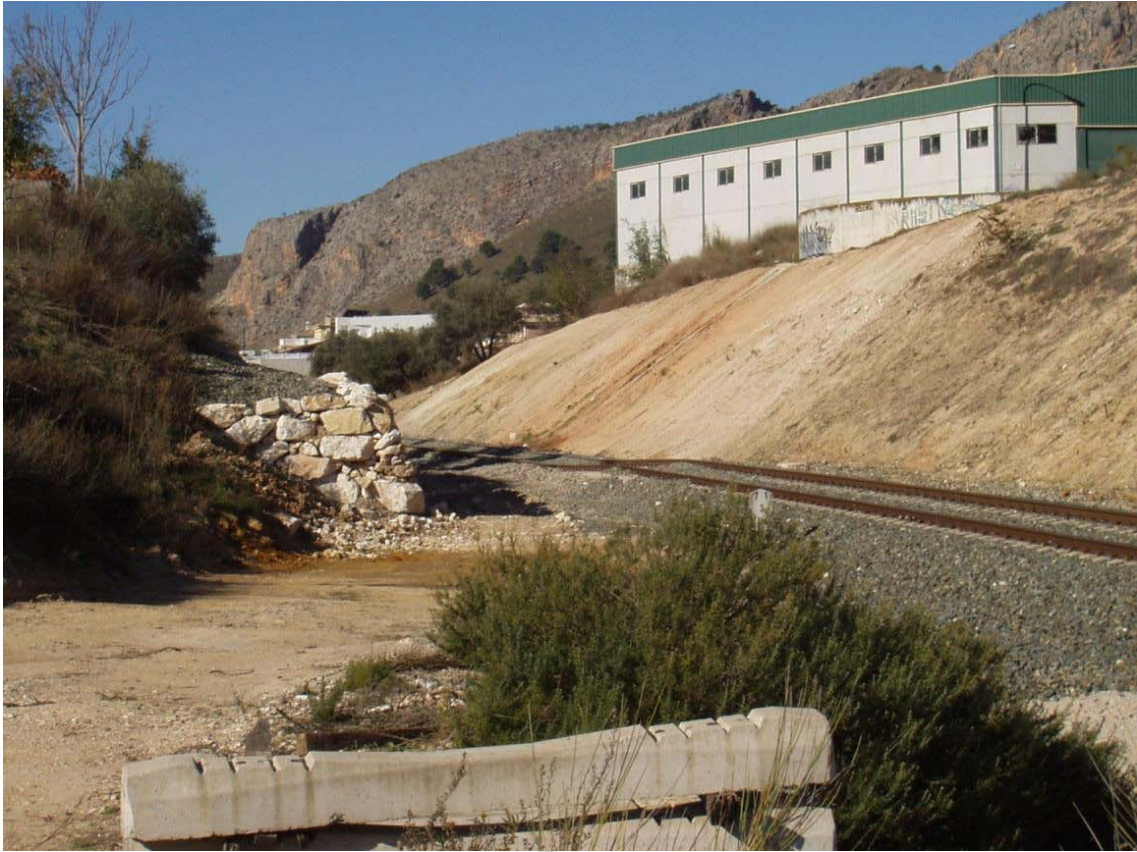
Acondicionamiento desmonts 43 y 44
