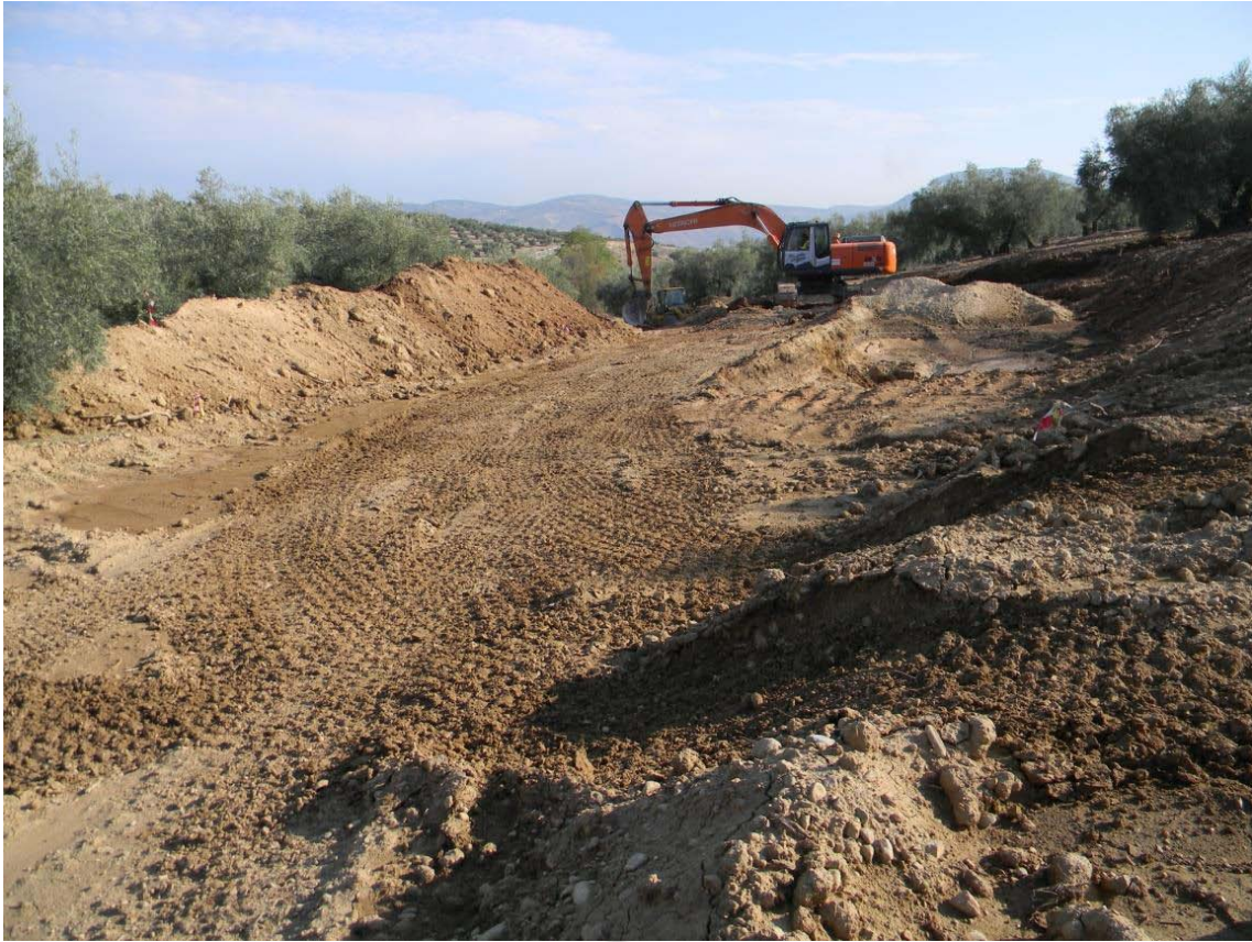
Desmante reposición carretera A-4153
