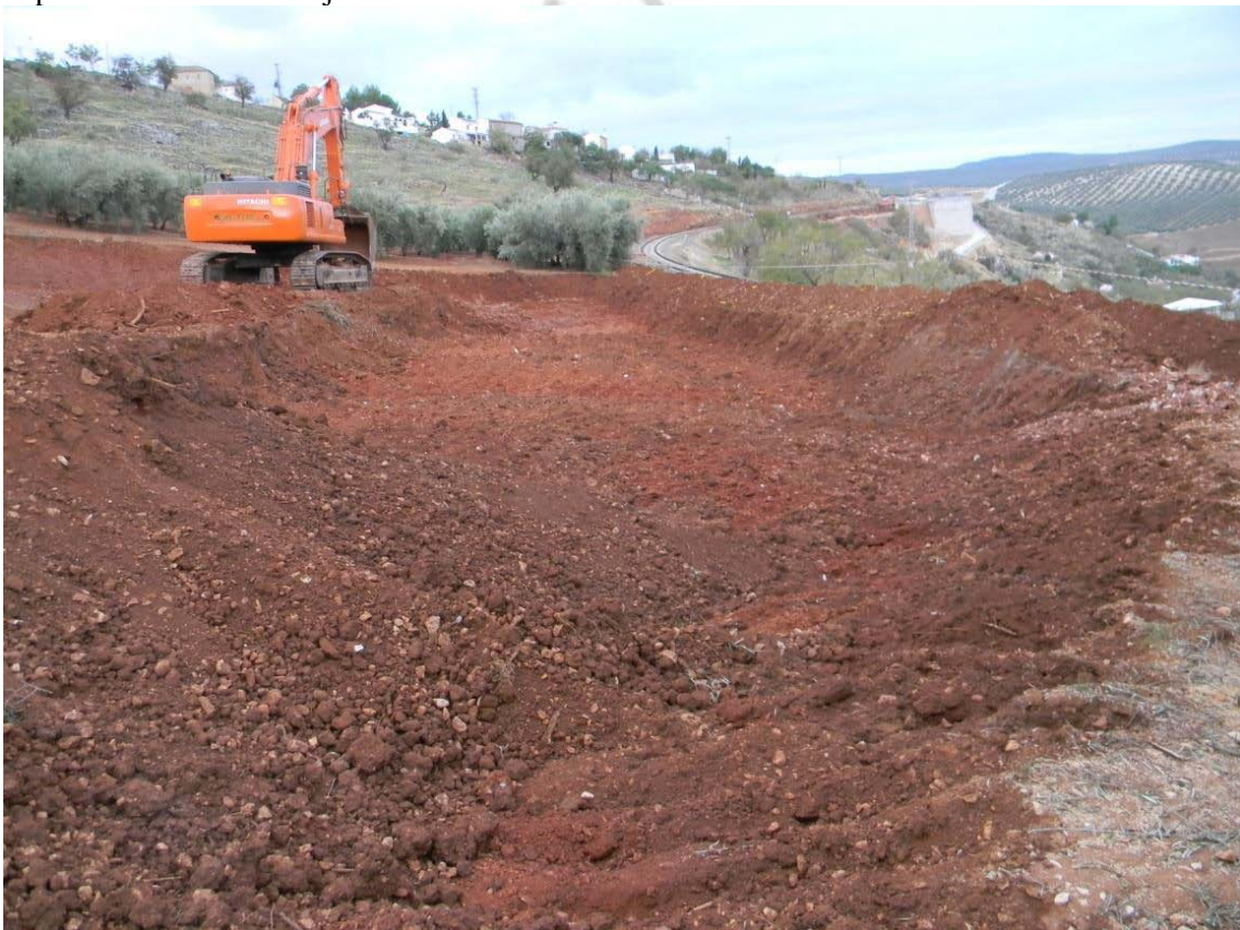
Reposición Carretera Atajea
