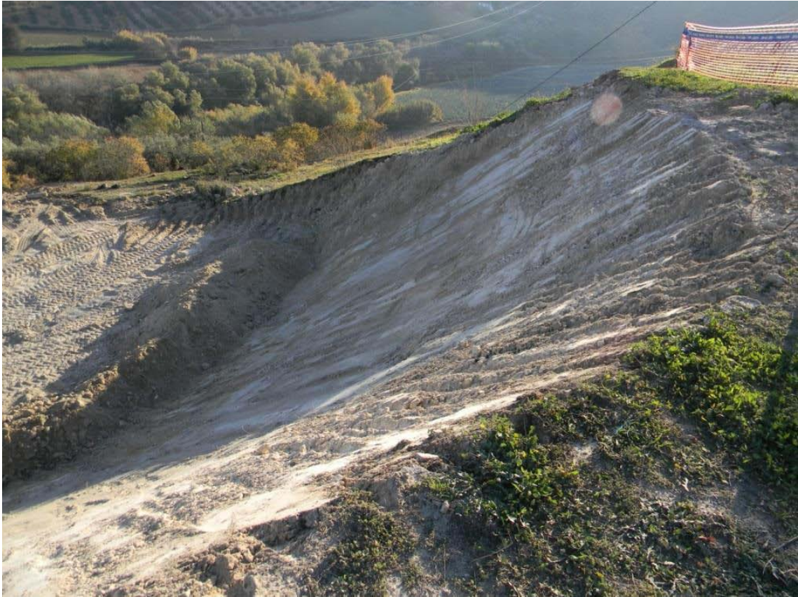
Talud desmonte P.K. 7+360
