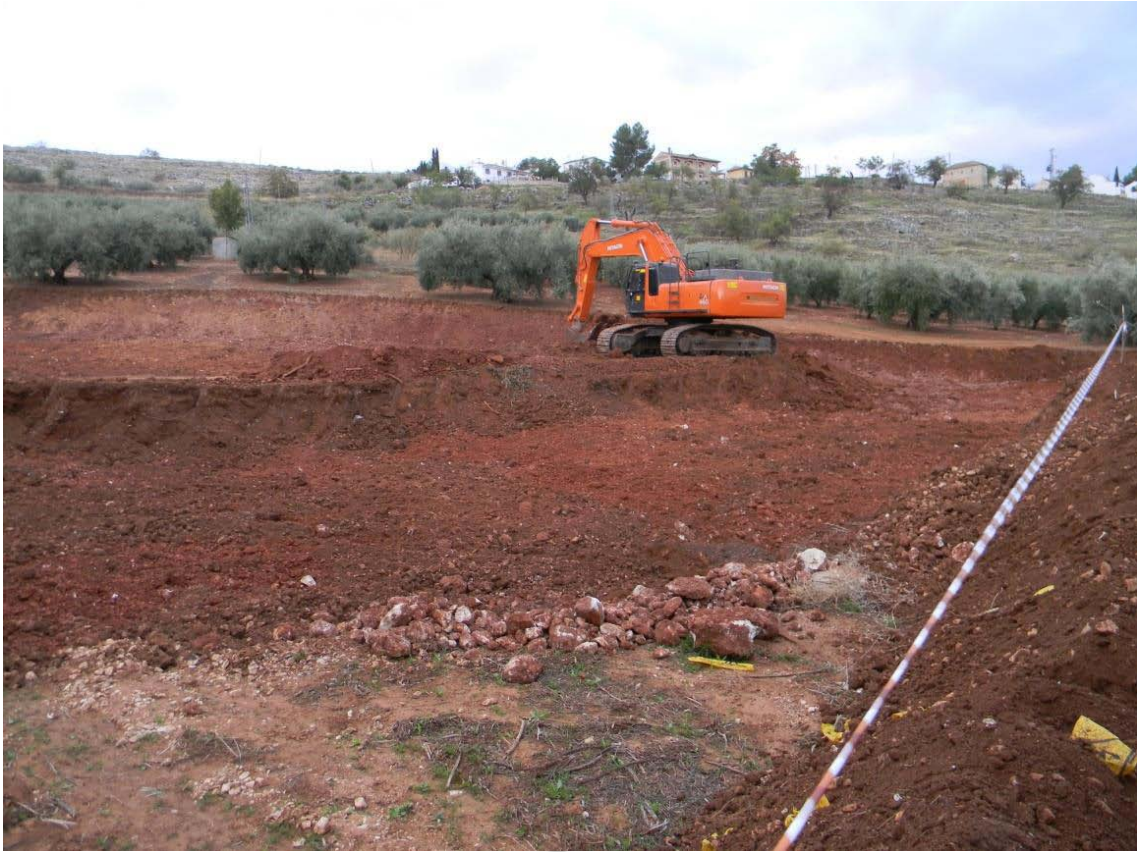
Reposición Carretera Atajea
