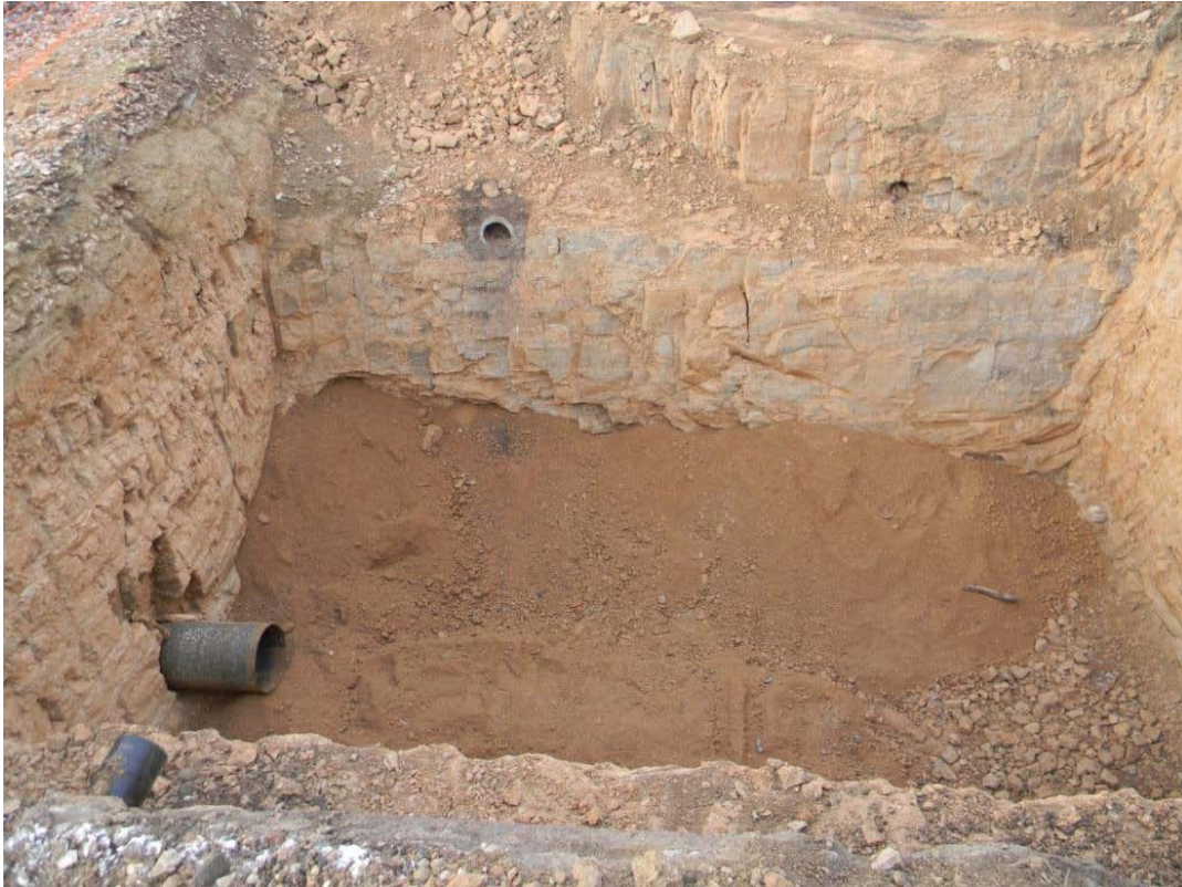
Reposición de servicios en Apeadero de Riofrío
