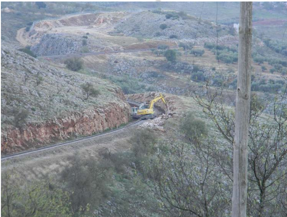
Trabajos sobre desmonte en roca P.K.1+900
