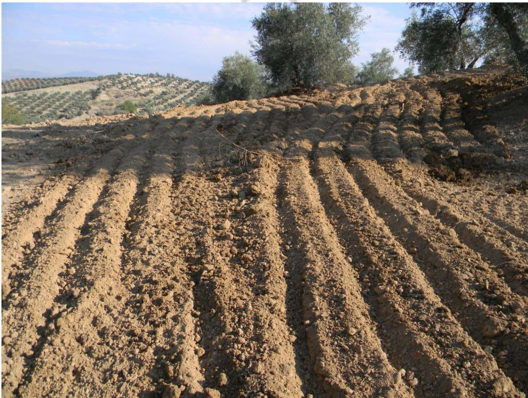
Desmonte reposición carretera A-4153
