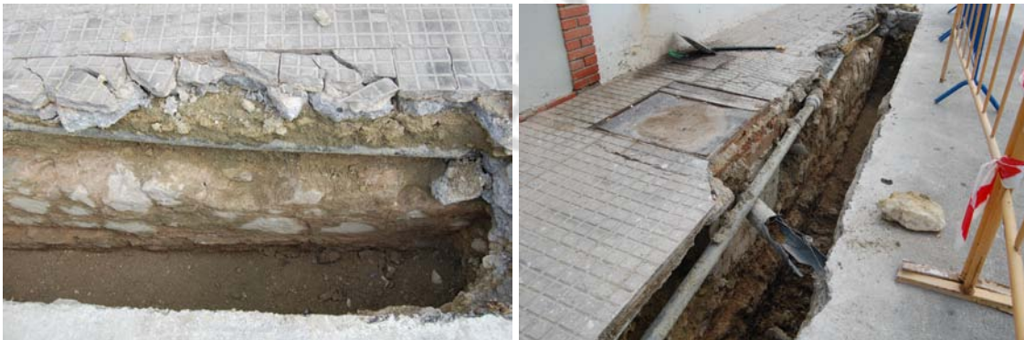
Láminas 5 y 6. Muro en la calle José García Berdoy.
