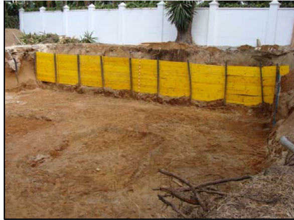
lám. g. Perfil Norte, estado final tras su estabilización.
