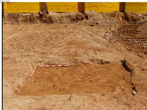
lám. i. Estado final del rebaje para la zapata del pilar 6, vista desde el sur.
